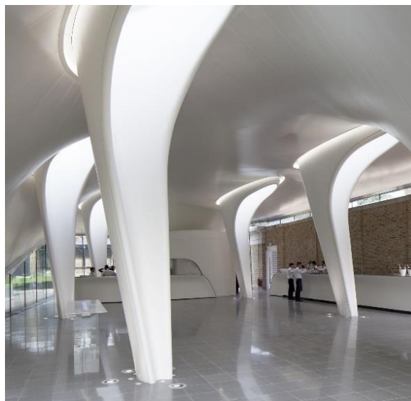
Figura II- 16 Columnas no prismáticas configuradas en una estructura contemporánea
