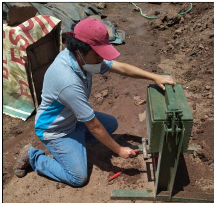
Figura 113: Compactación de Adobe por medio de Apalancar las Gatas Hidráulicas
