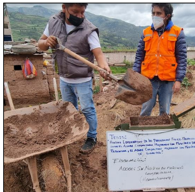
Figura 119: Suministro de Material para Compactar a la Máquina
