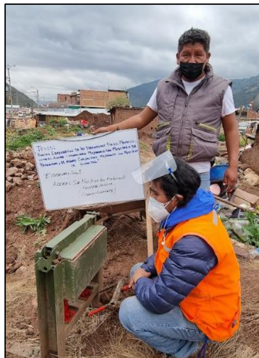
Figura 121: Empuje Hidráulico con la Gata para Compresión de la Máquina
