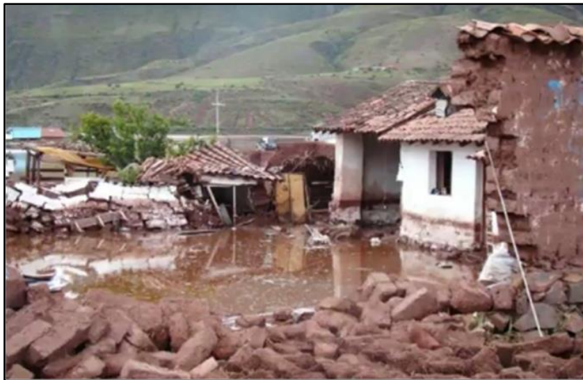
Figura 1: Daños a las Viviendas de Adobe producto de Inundación
