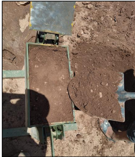
Figura 112: Suministro de Material a la Maquina Compactadora
