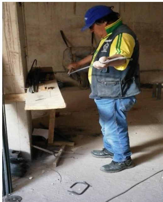
Figura 13. Trabajador colocando el tubo para doblar.
