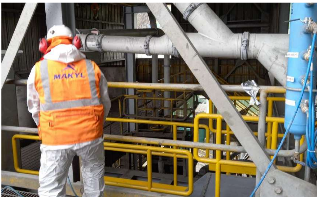
Figura 14: Instalación de sensores
