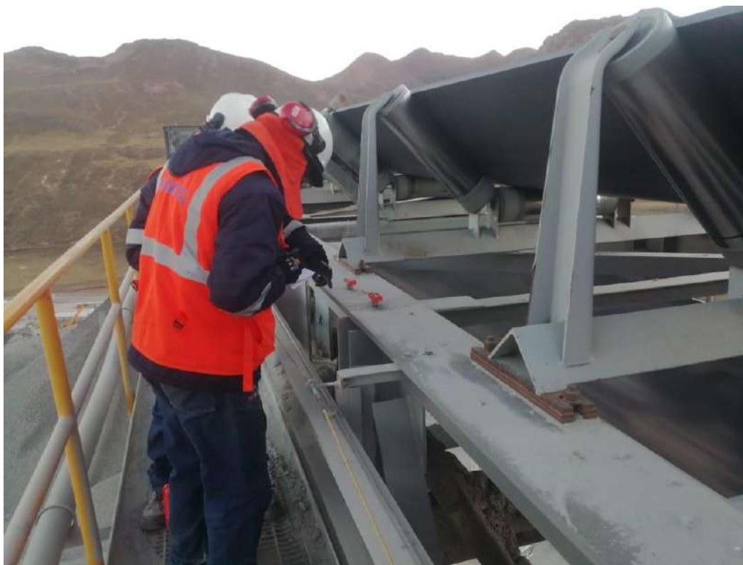
Figura 17: Instalación de sensores
