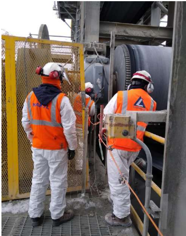
Figura 7: Inspección de activo
