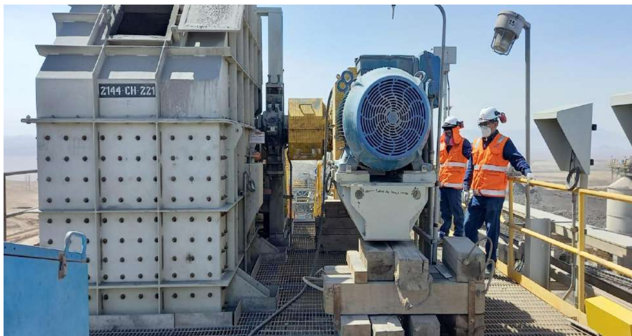
Figura 5: Inspección visual del activo
