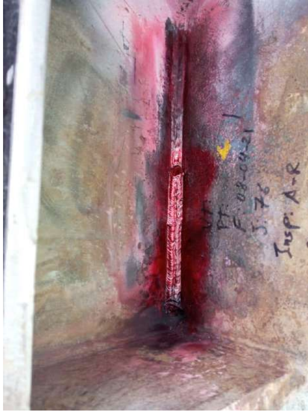
Figura 11: Ensayos no destructivos NDT
