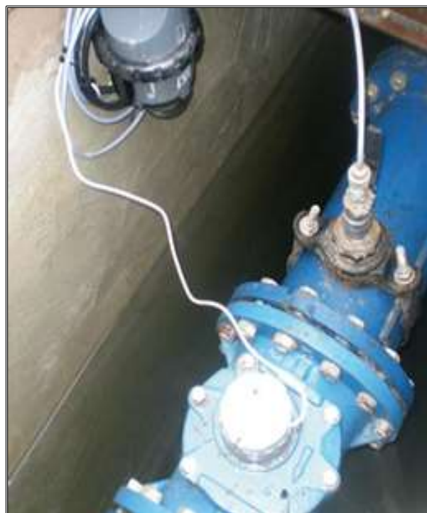
Figura N° 59. Instalación de Data Logger - Sub Zona 6F-1.
