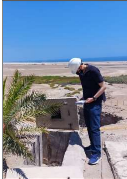
Figura N° 58. Cámara de Monitoreo Sub Zona 6F-1 – Urb. Las Glorietas – Villa Municipal
