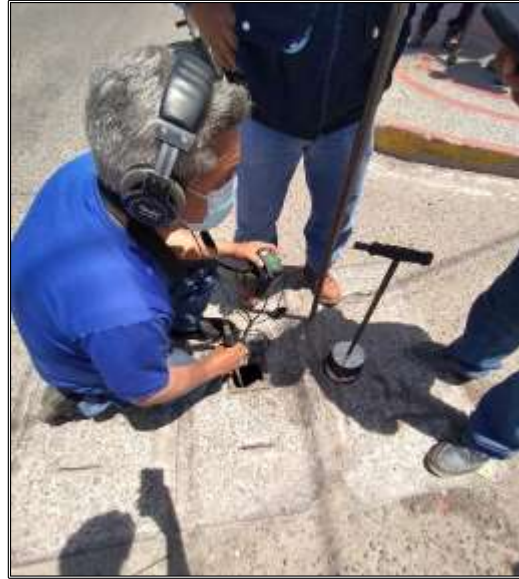
Figura N° 41. Verificación de Hermeticidad en Válvulas con geófono Acústico Fuente: Elaboración propia
