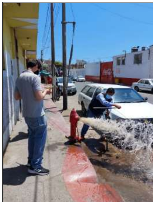
Figura N° 31. Toma de datos, purgas en redes Fuente: Elaboración propia
