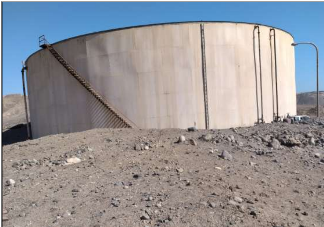
Reservorio (R-6) – Reservorio Metálico
