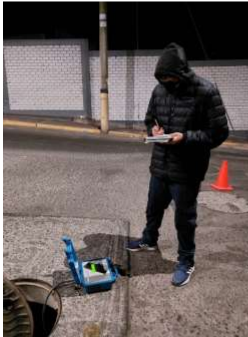
Figura N° 51. Toma de lectura de caudal y volumen acumulado, cada 10min.
