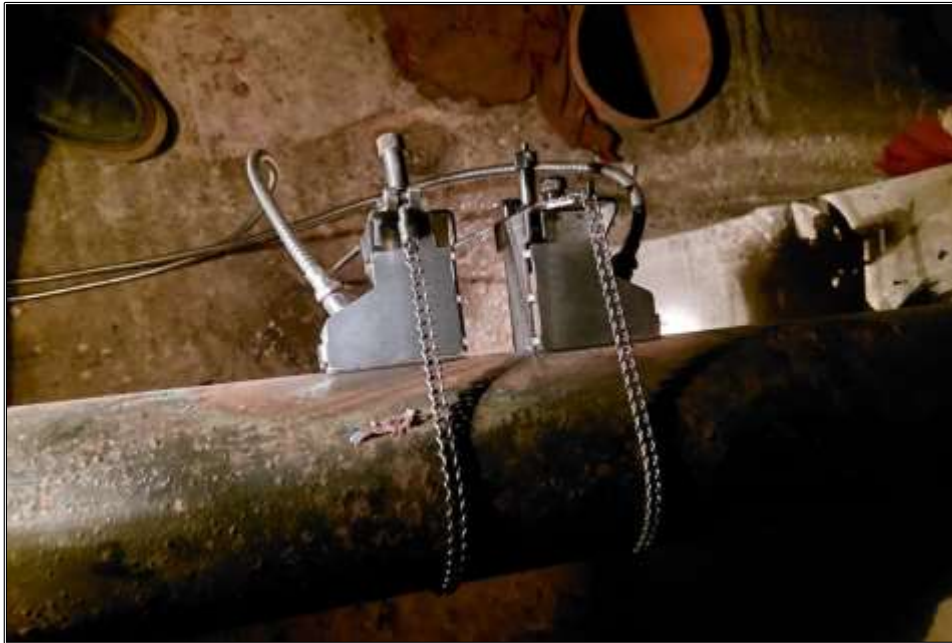
Figura N° 49. Instalación de Caudalímetro en la tubería de ingreso. Fuente: Elaboración propia
