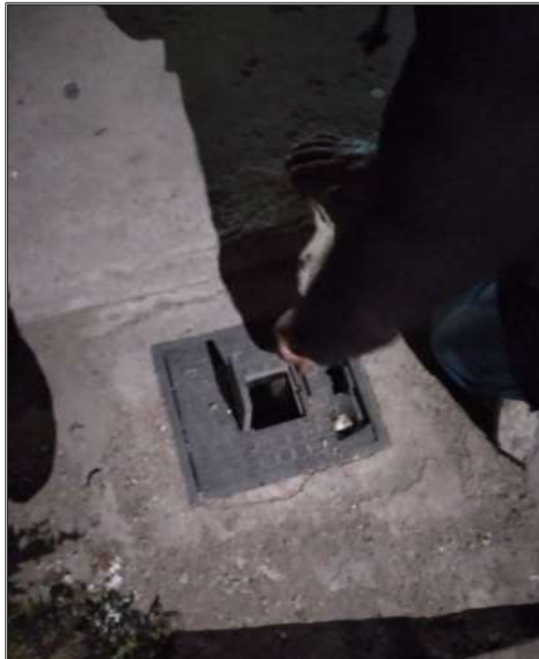
Figura N° 45. Cierre de conexiones Domiciliarias – Sub Zona 2B-3 – Urb. San Pedro Fuente: Elaboración propia
