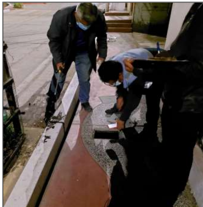
Figura N° 48. Cierre de conexiones Domiciliarias – Sub Zona 6F-1 – Urb. Villa Municipal
