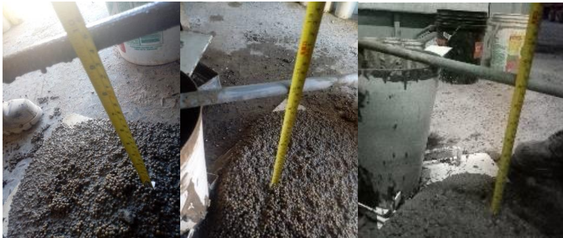
Figura 44: Asentamiento del hormigón
