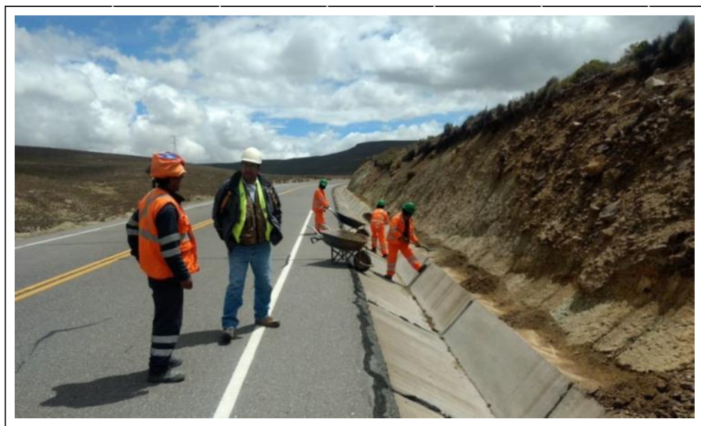
Figura 38: Supervisión in Situ. Limpieza de cunetas.
