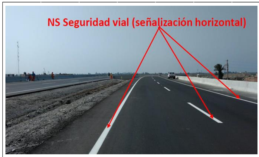
Figura 28: Niveles de servicio para seguridad vial (señalización horizontal).
