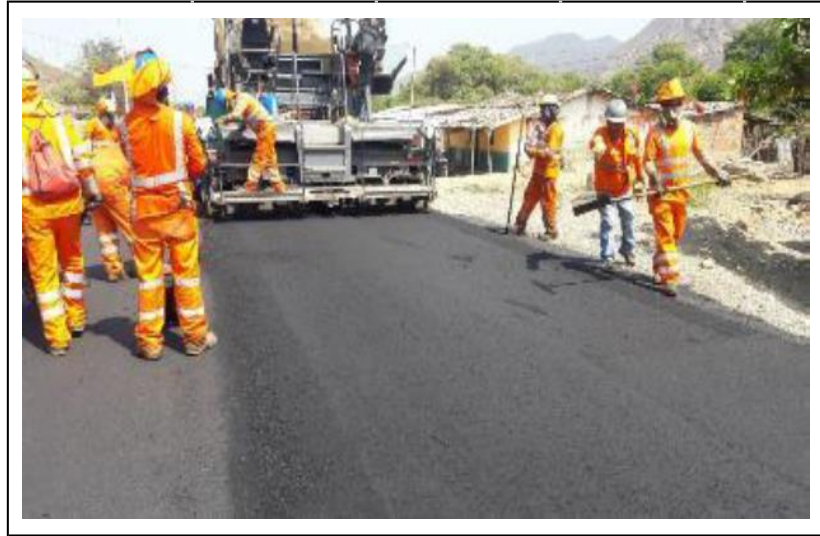
Figura 26: Aplicación de Slurry Seal
