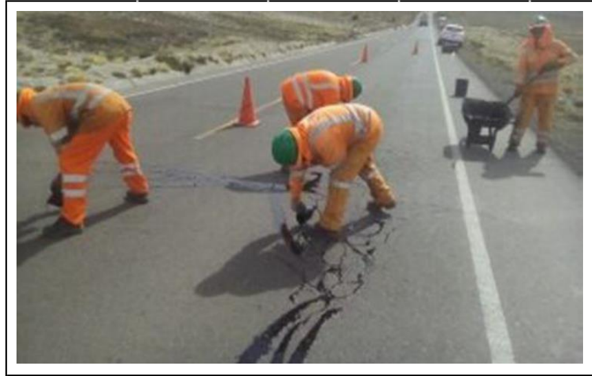
Figura 20: Tratamiento de fisuras en Calzada.
