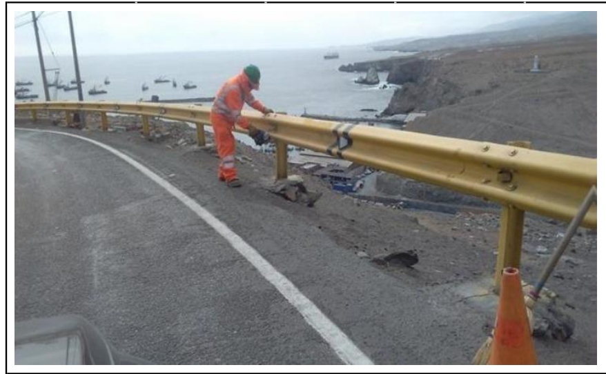
Figura 18: Limpieza de guardavías.
