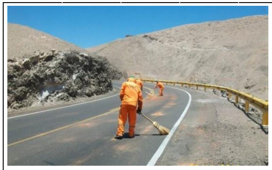
Figura 19: Limpieza de Calzada.
