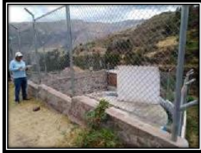
FIGURA N° 121 CERCO PERIMETRICO EN EVALUACION
