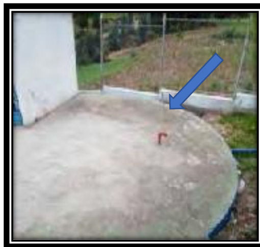
FIGURA N° 129 TUBO DE VENTILACIÓN
