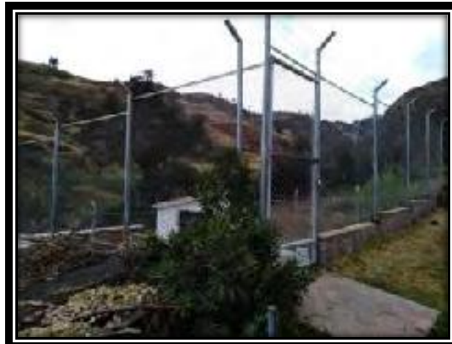
FIGURA N° 123 CERCO PERIMETRICO EN RESERVORIO
