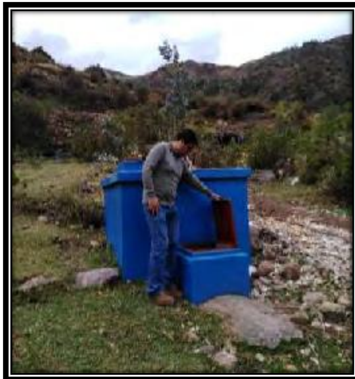
FIGURA N° 114 CÁMARA DE REUNIÓN 01 -PITIPUJIO 1
