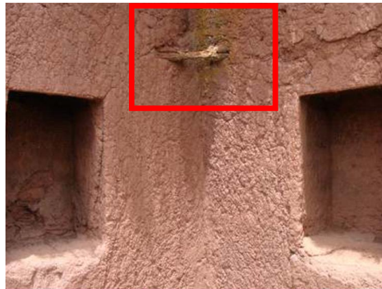
Figura 31. Refuerzo de llaves de madera en las uniones de muros
