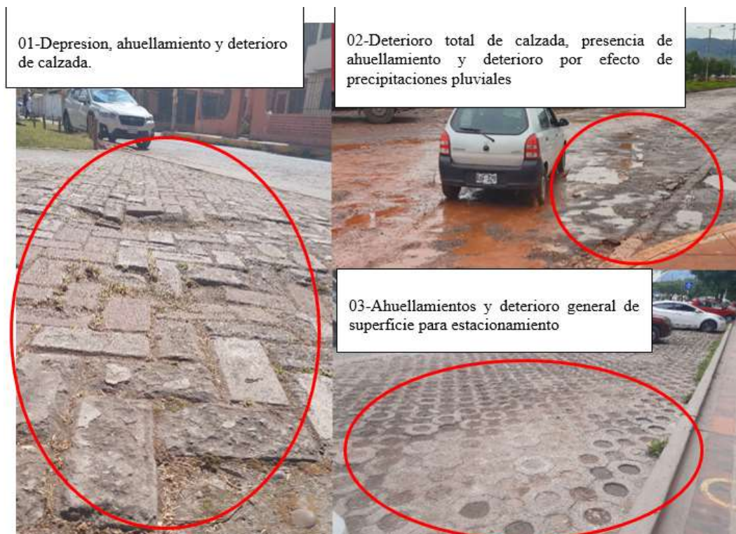
Figura 1-1 Estado de deterioro de calles de la ciudad del Cusco. 01: Parque amauta (Urb. Magisterio); 02: Vía Expresa con Av. República del Perú. (San Sebastián); 03 Av. De la Cultura (Wanchaq).
