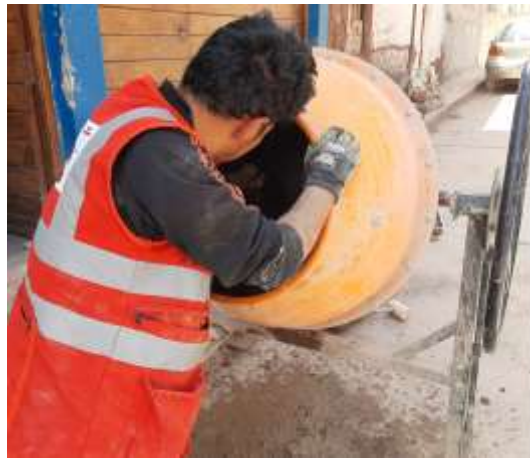
Figura 3-36 Colocacion de materiales para inicio de mezcla.
