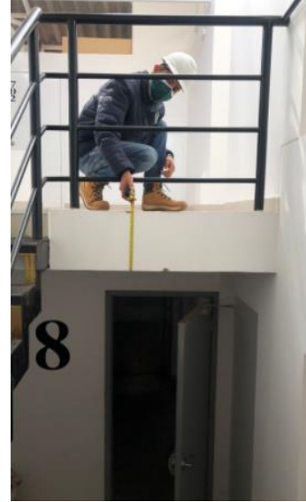
Fotografía N°22: Medida del espesor de losa
