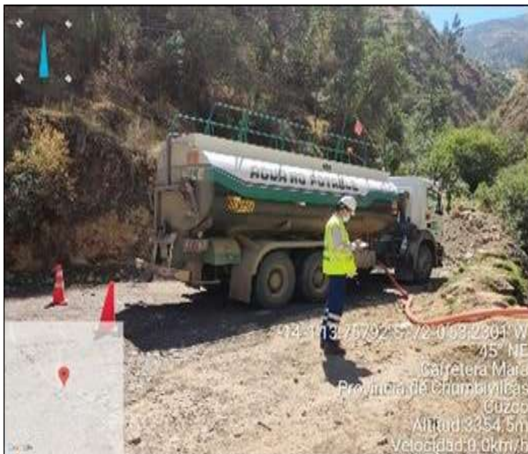
Figura 7 Carguío de agua para aplicación del supresor (DASAUT + agua)
