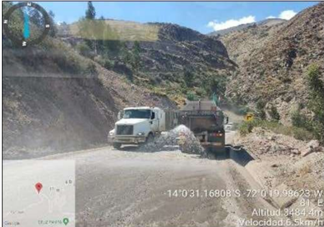
Figura 9 Riego de vía con el supresor (DASAUT + agua)
