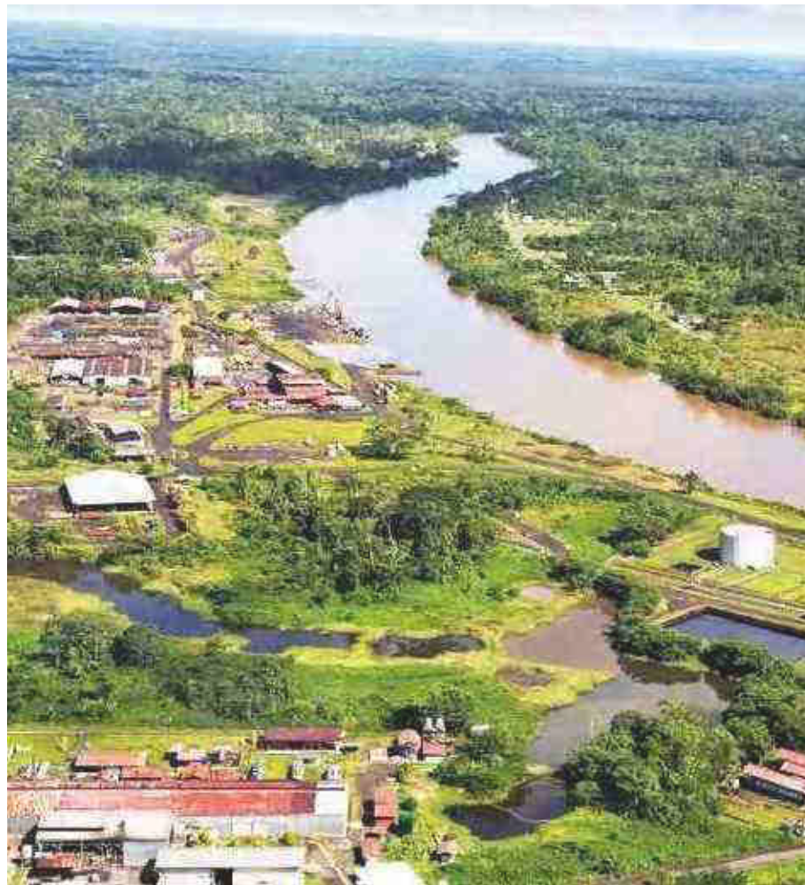
Planta y Villa Trompeteros, Lote 8. Foto GFHL-Osinermin.
