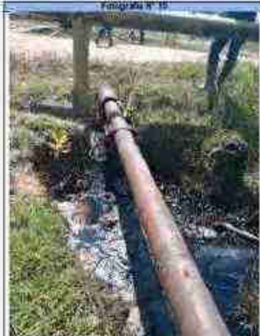
Fotografía N° 15.- Vista de la tubería al otro extremo de la conducción, donde se puede observar esta formada por piezas de tubos de hierro a lo largo de la línea de tubo.
