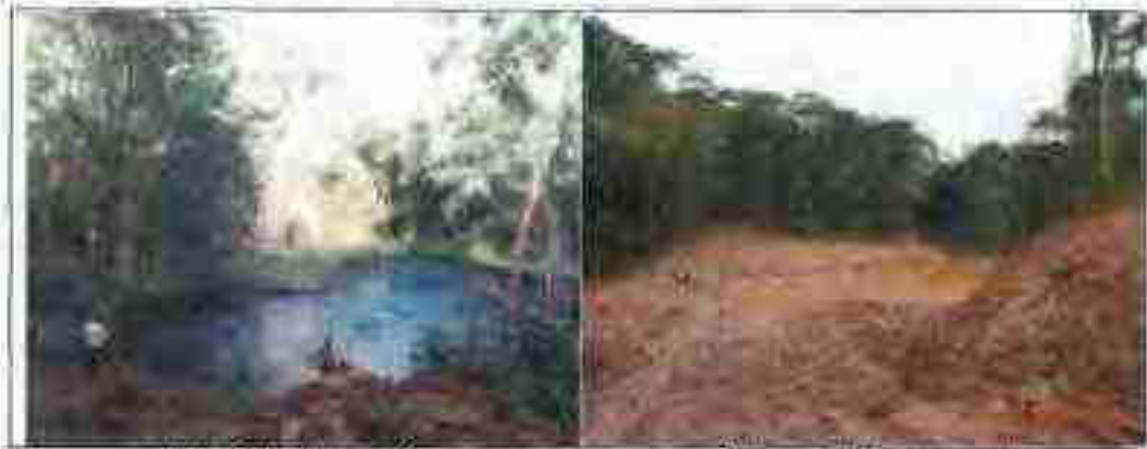
Antes de la intervención
