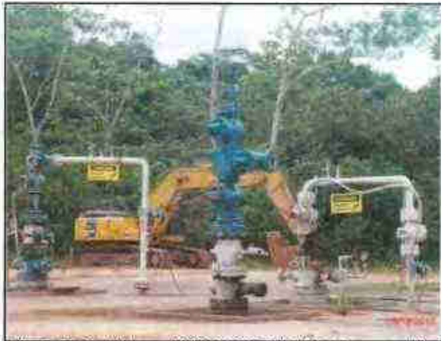
Fotografía N° 13 del Informe N° 219883-2012-GFHL-UPPD: Se muestra el Pozo CS-18 en estado productor, el Pozo CS-19 estado ATA y Pozo CS 20 inyector de agua de producción. Cabezal del pozo productor manchado con petróleo por fuga en el remanente.
