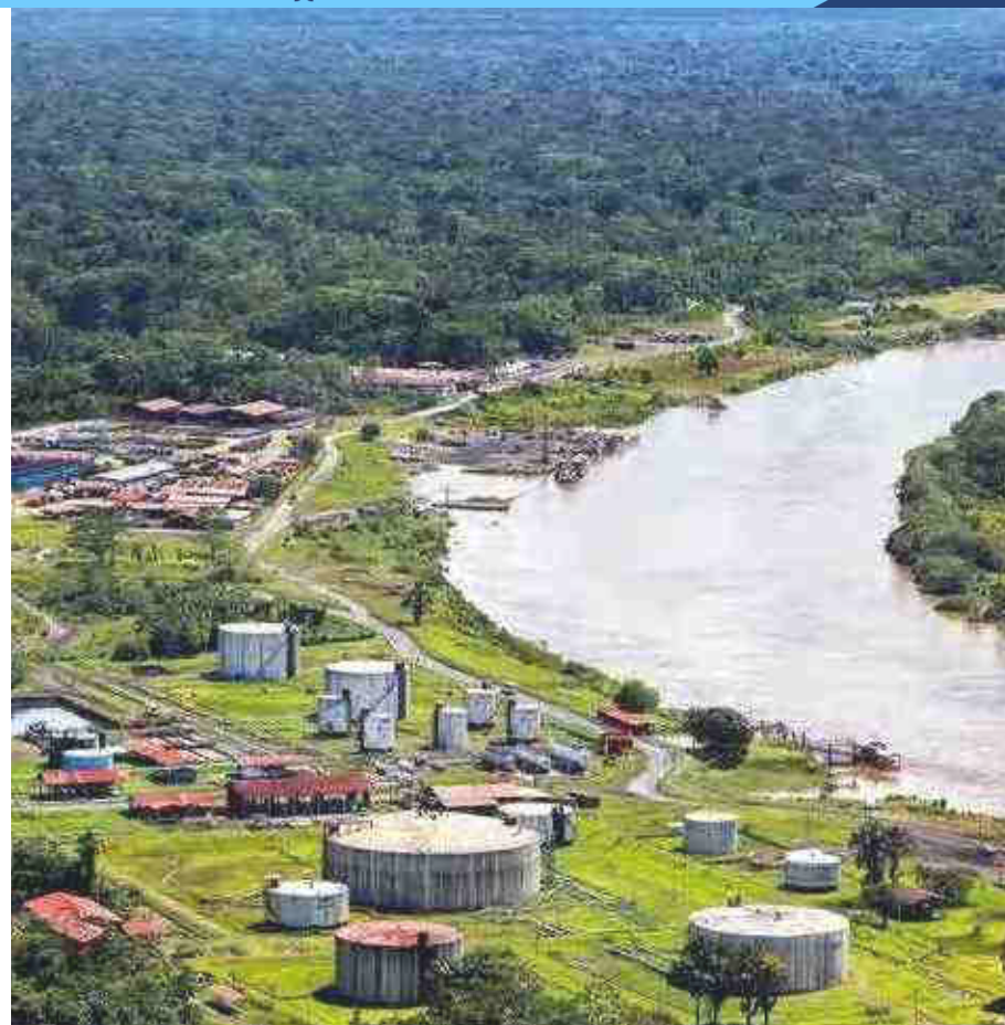
Lote 8. Foto GFHL-Osinergmin.
