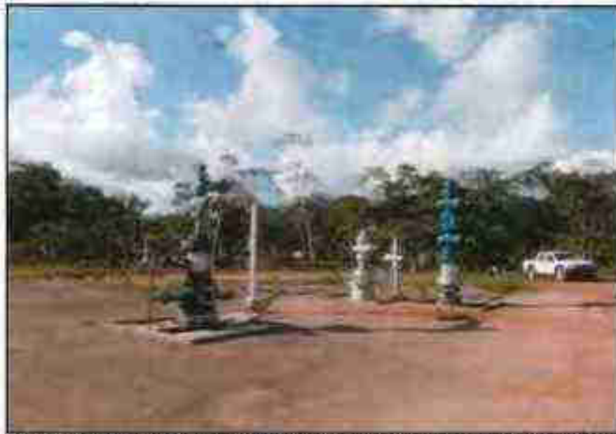
Fotografía N° 1 del Informe N° 692-2012-OEFA/DS: Vista del Pozo CS20 del Yacimiento Capahuari Sur.
