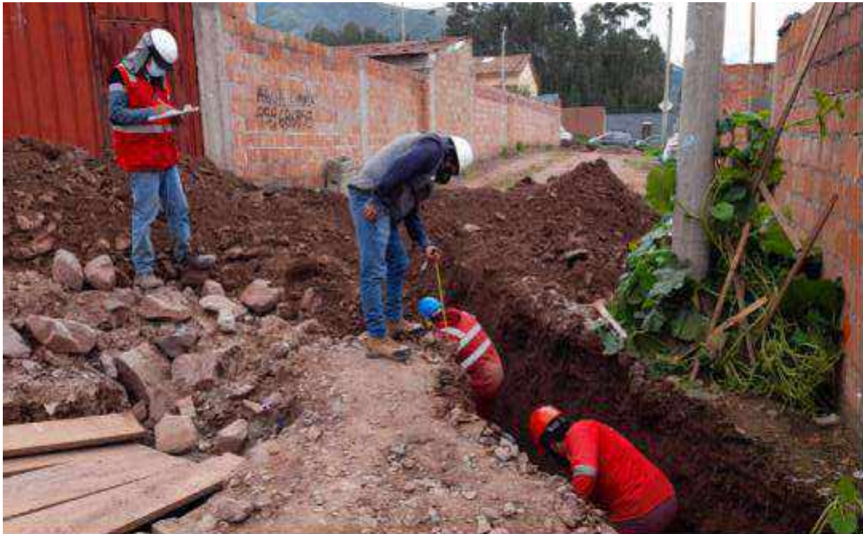
Figura 15 Control de avance de obra y toma de datos carta balance.
