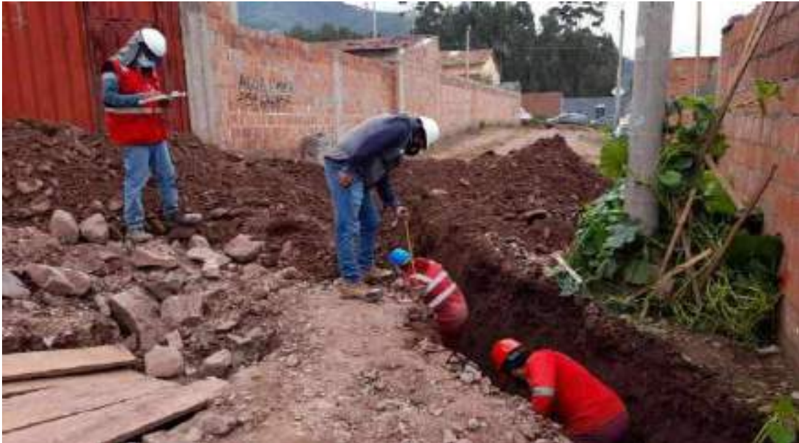
Figura 2. Medición insitu de rendimiento de conexión domiciliar de red de desague:
