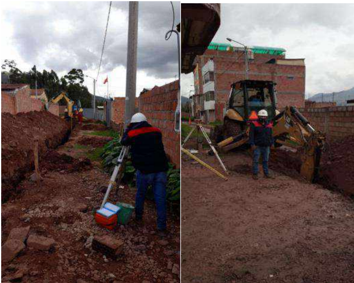
Figura 13 Investigador realizando nivelaciones topográficas.
