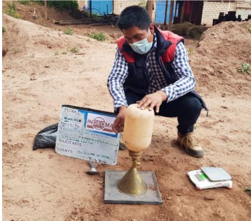
Figura N° 10. Equipos para realizar ensayo de densidad de campo.
