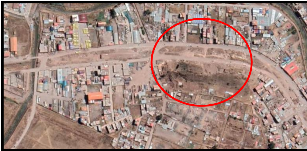
Figura 3. Vía Expresa de Cusco km 04+500.
