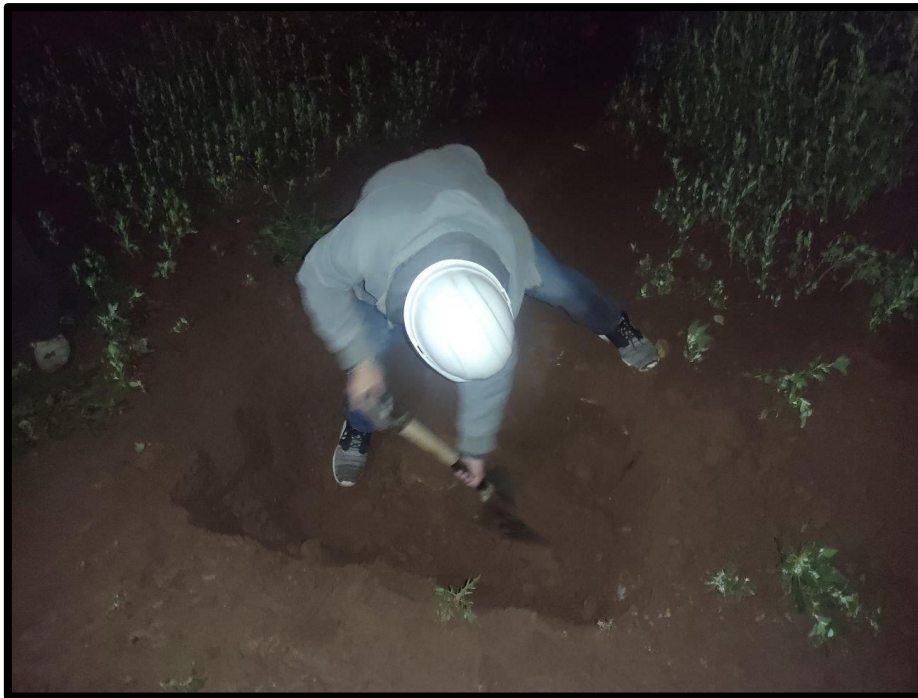
Figura 28. Excavación de Calicata 2 (C-2).
