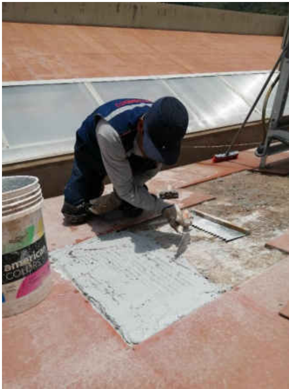
Figura 9: Colaborador realizando Act. Albañilería
