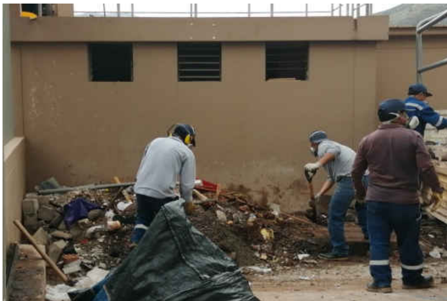
Figura 11: Colaboradores realizando Act. de limpieza de desmonte
