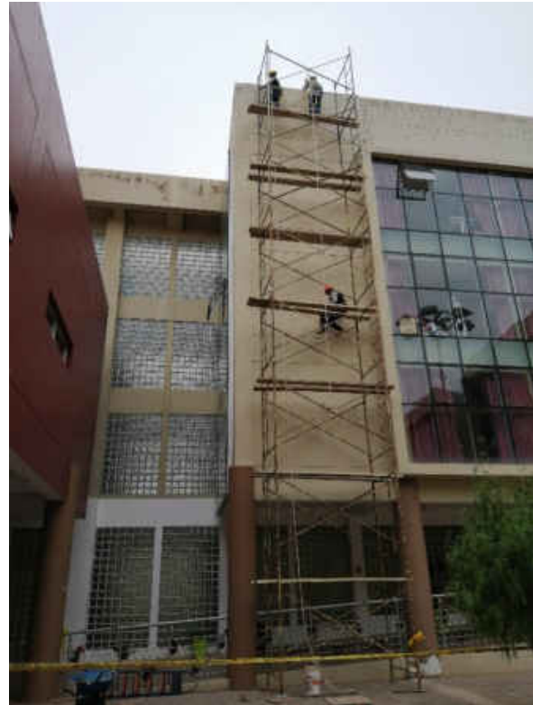
Figura 2: Colaboradores realizando Trabajos en Altura
