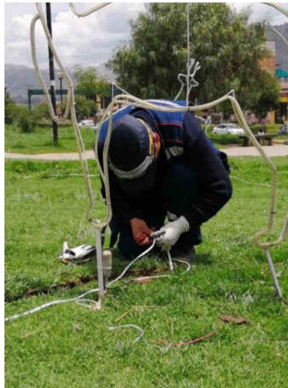
Figura 4: Colaborador realizando Trabajos Eléctricos
