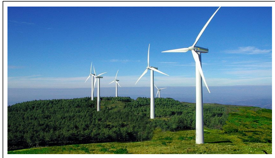
Figura 2.8. Parque de Generación de Energía Eólica
