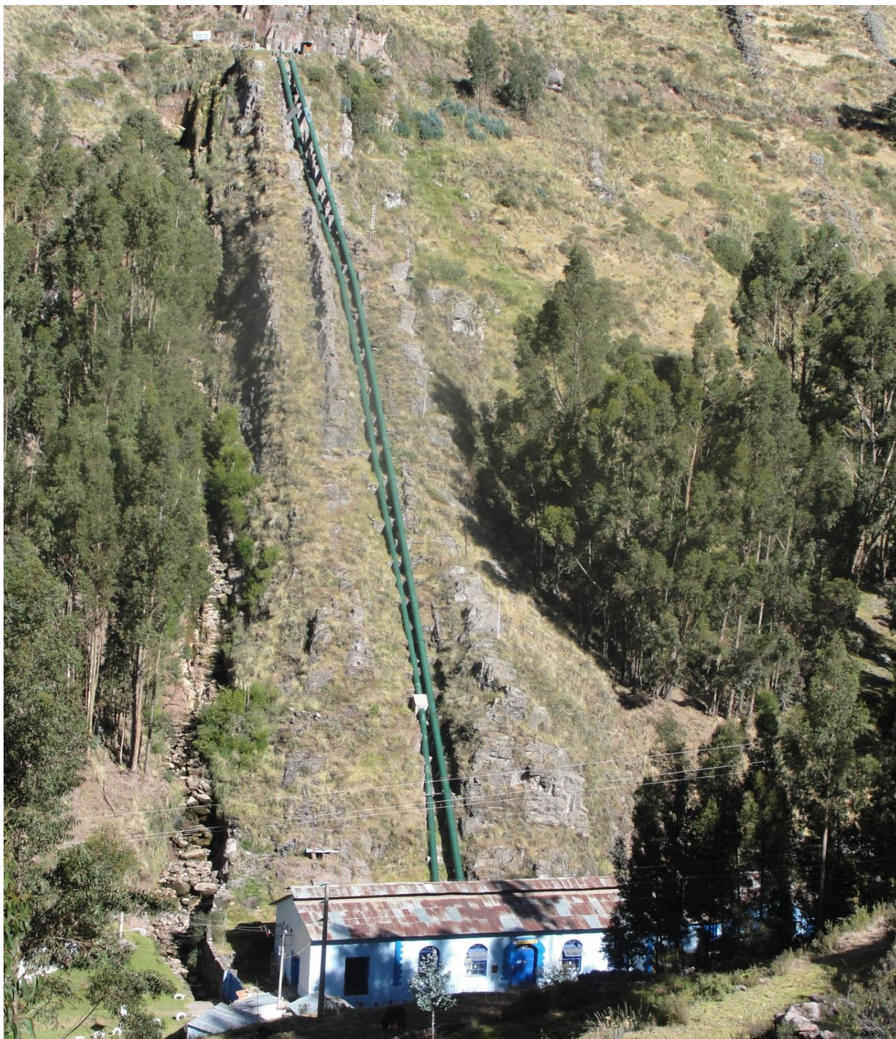
Foto 05: Vista panorámica de la central hidroeléctrica de hercca
