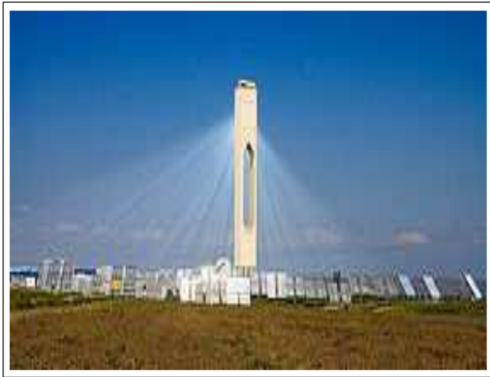
Figura 2.11. Central De Generación Solar Térmica
