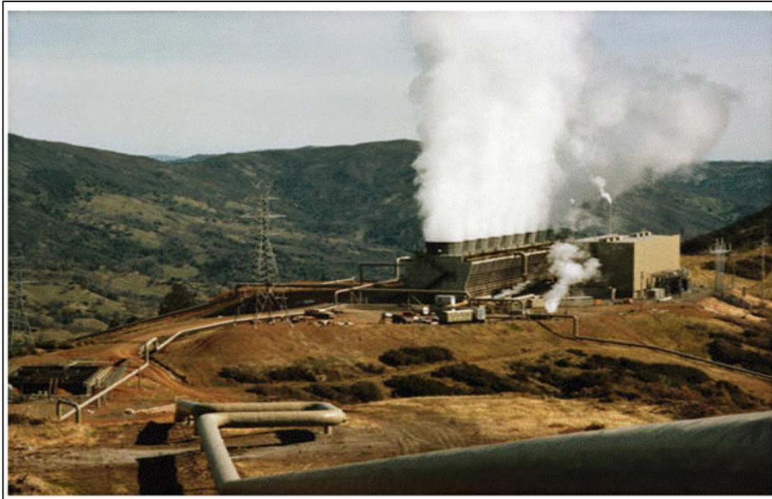
Figura 2.14. Fuente de energía geotérmica con emisiones de vapor de un central seco
