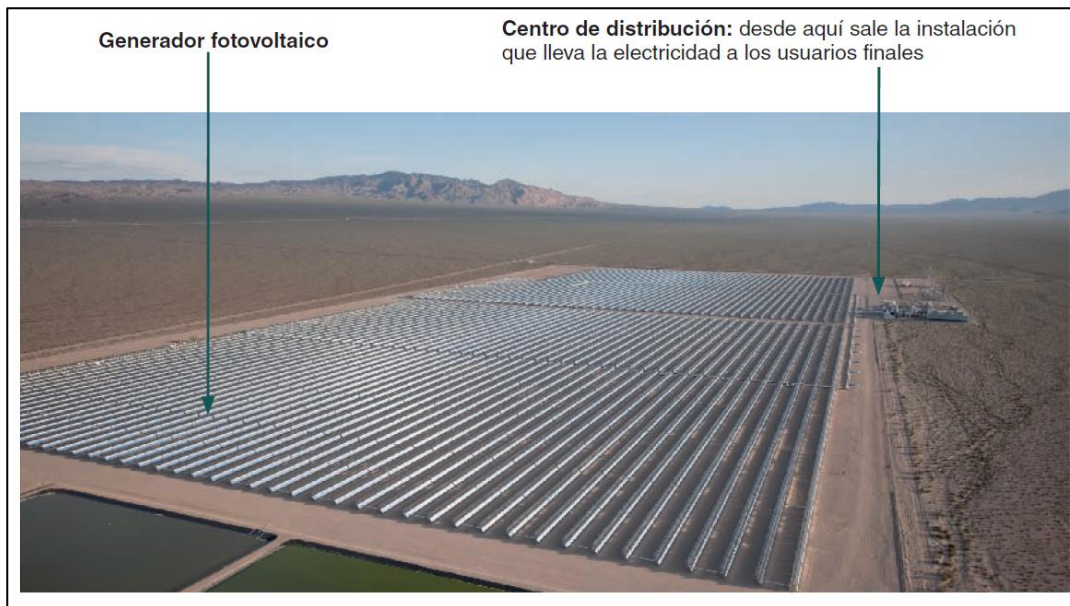
Figura 2.10. Central de Generación Solar Fotovoltaica aislada
