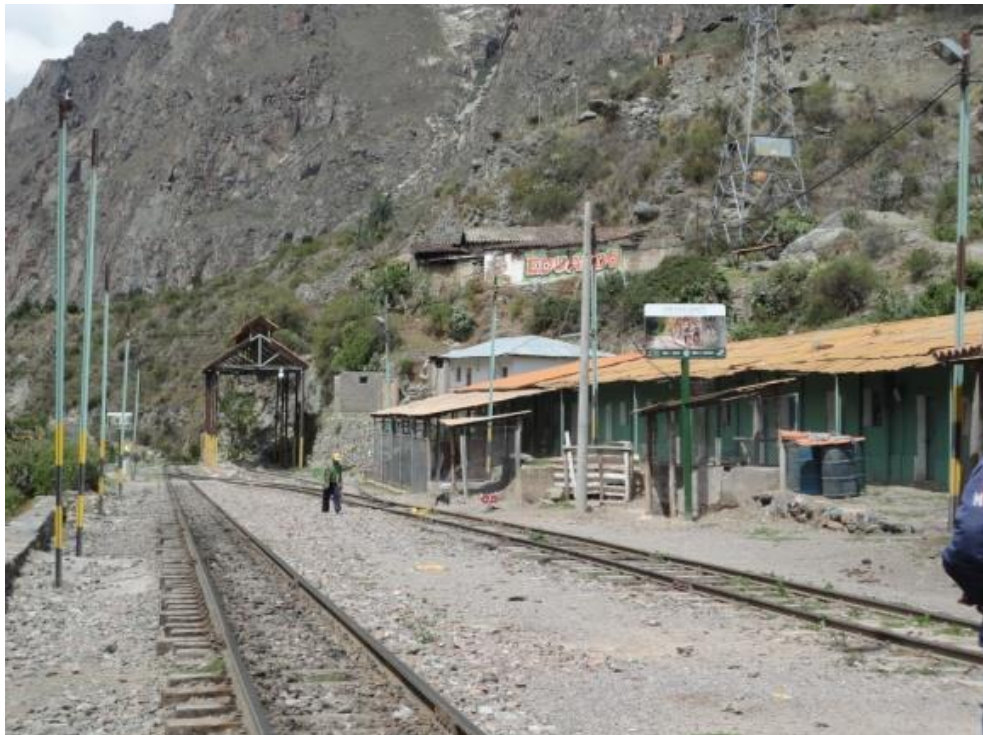
Figura 21 Estación Km 82 en el pueblo de Piscacucho
