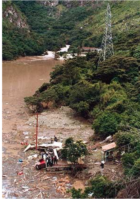
Figura 16 Destrucción de la vía santa teresa
