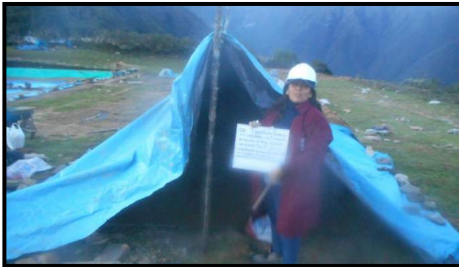
Figura 47: Protección de los paneles y bloques durante el proceso de secado Fuente: Propia
