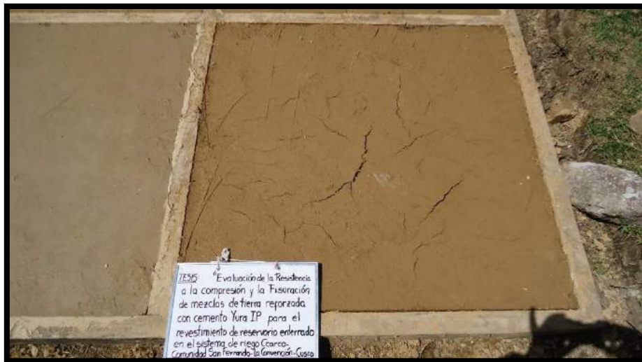
Figura 52: Panel con mezcla de testigo que evidencia la formación excesiva de fisuras Fuente: Propia
