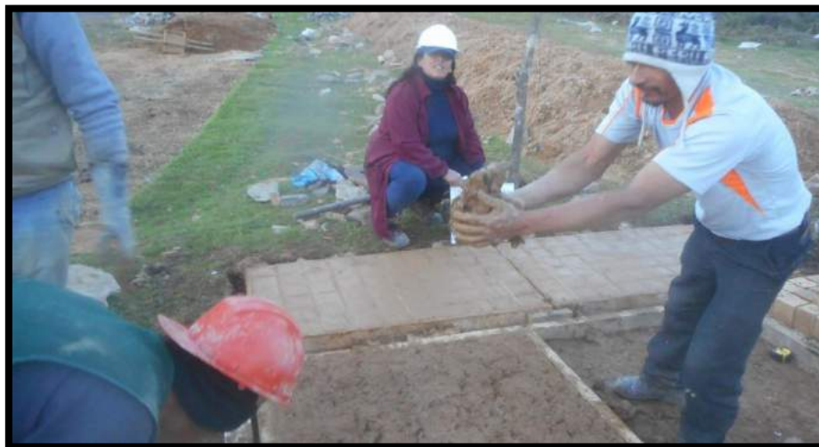
Figura 45: Proceso de lanzamiento de mezcla en paneles para el ensayo de fisuración Fuente: Propia
