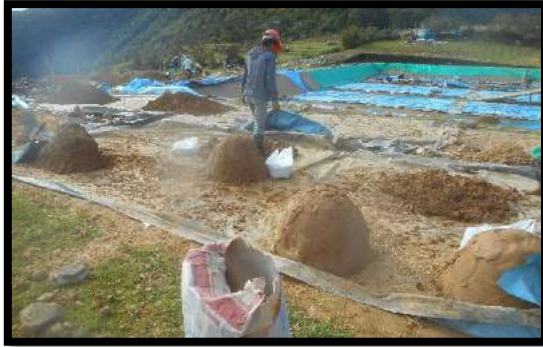
Figura 43: Incorporación de cemento para el amasado final de las mezclas Fuente: Propia
