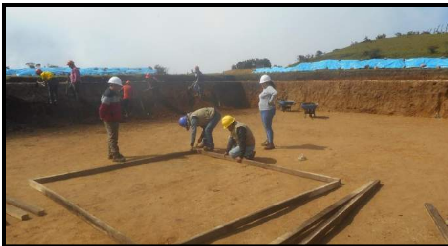
Figura 39: Armado de paneles para el ensayo de fisuración Fuente: Propia
