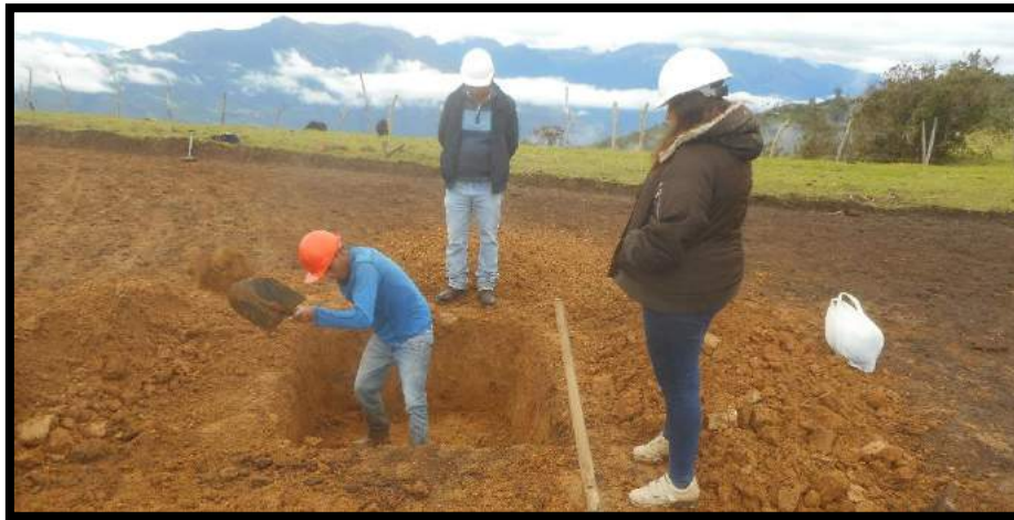
Figura 16: Excavación de calicata
