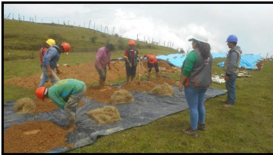
Figura 35: Proceso de amasado inicial Fuente: Propia
