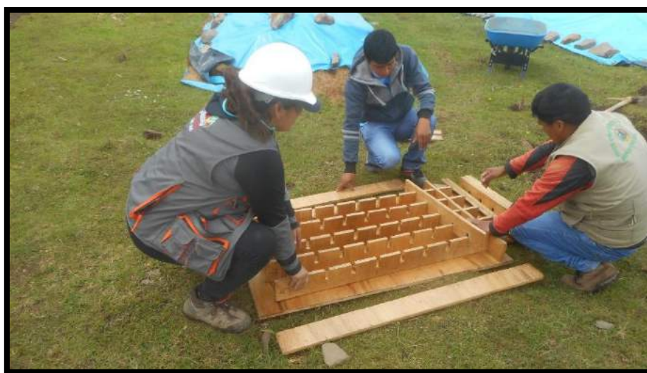
Figura 42: Verificación de medidas y ensamblado de moldes
