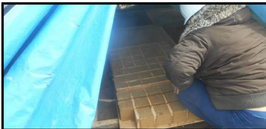
Figura 48: Desmoldado de bloques durante el proceso de secado a los 2 días Fuente: Propia
