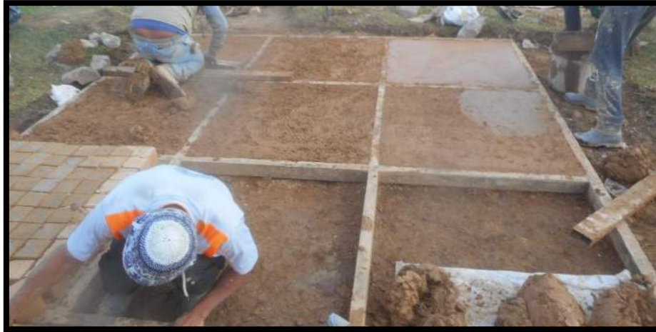
Figura 46: Enlucido de los paneles luego del lanzado y moldeado de mezcla Fuente: Propia
