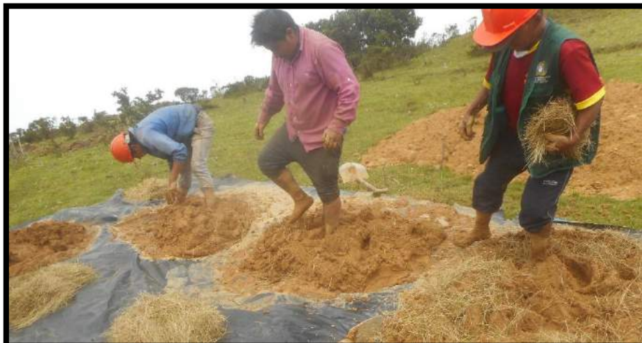
Figura 35: Proceso de amasado inicial Fuente: Propia
