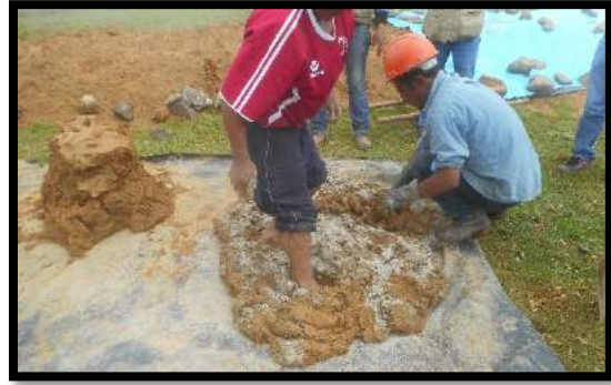
Figura 43: Incorporación de cemento para el amasado final de las mezclas Fuente: Propia
