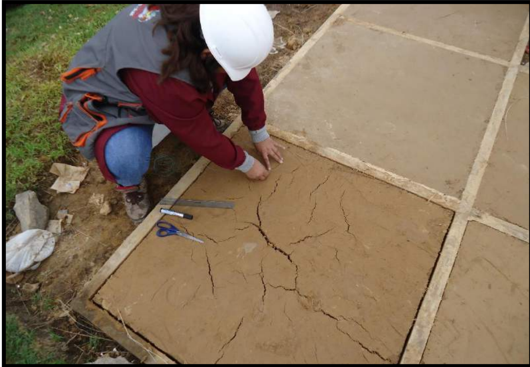
Figura 54: Toma de medida con hilo nylon en las fisuras (M1) a los 14 días de secado Fuente: Propia
