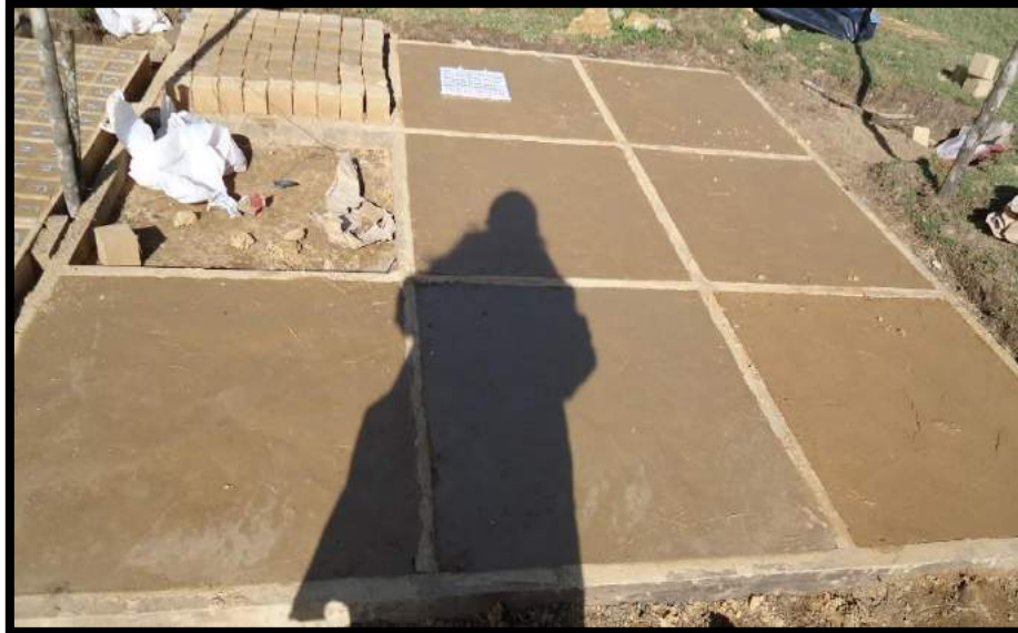
Figura 49: Paneles para evaluación de fisuración a los 2 días de secado Fuente: Propia
