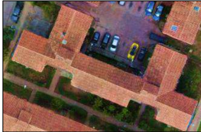
Figura 34 Edificación "D-5" - "D-6"
