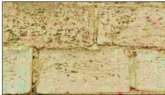
Figura 31 Pilas de bloqueta de concreto de edificación
