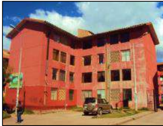
Figura 14 Estado actual de las edificaciones
