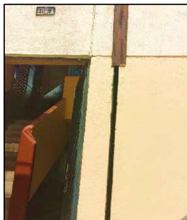
Figura 17 Junta sísmica de 3.5 cm
