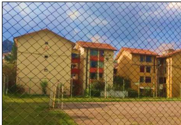
Figura 29 Edificaciones B-2, B-4, C-2, C-4 y D-2
