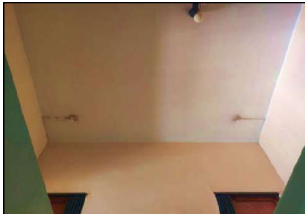
Figura 37 Cobertura de edificación
