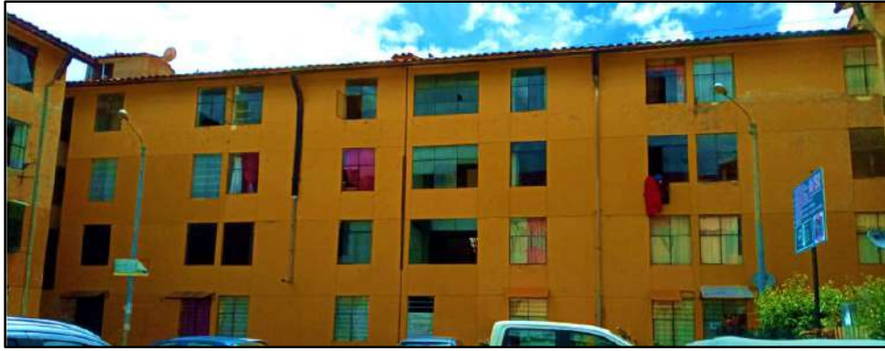
Figura 13 Inspección de las edificaciones
