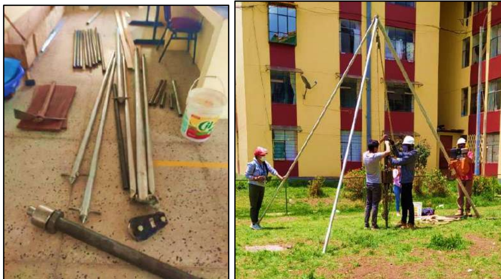
Figura 10 a) Equipo de penetración y b) Armado del equipo SPT
