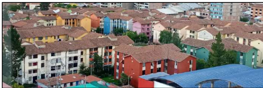
Figura 36 Cubiertas bien conectadas a paneles de muros de albañilería (no presentan viga de soporte)
