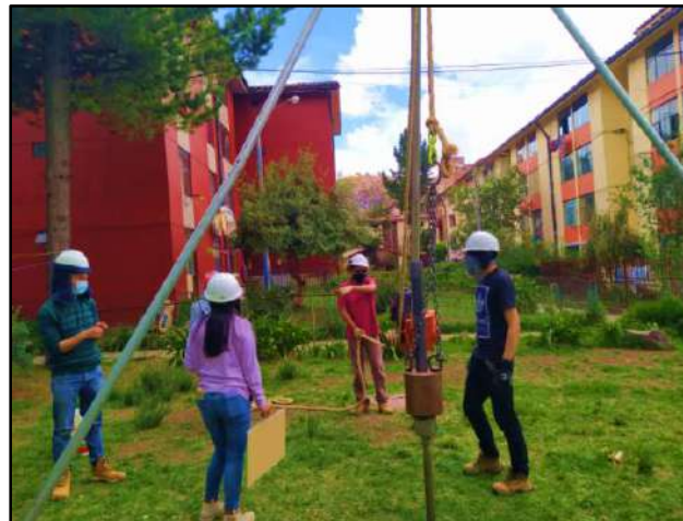
Figura 23 Elaboración ensayo SPT
