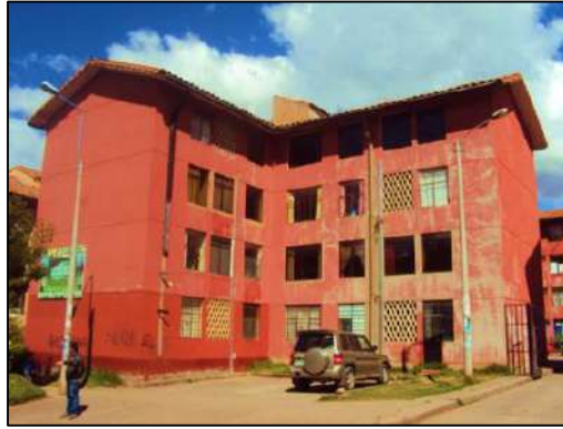
Figura 30 Edificación "C-4" del Conjunto Habitacional Pachacutec
