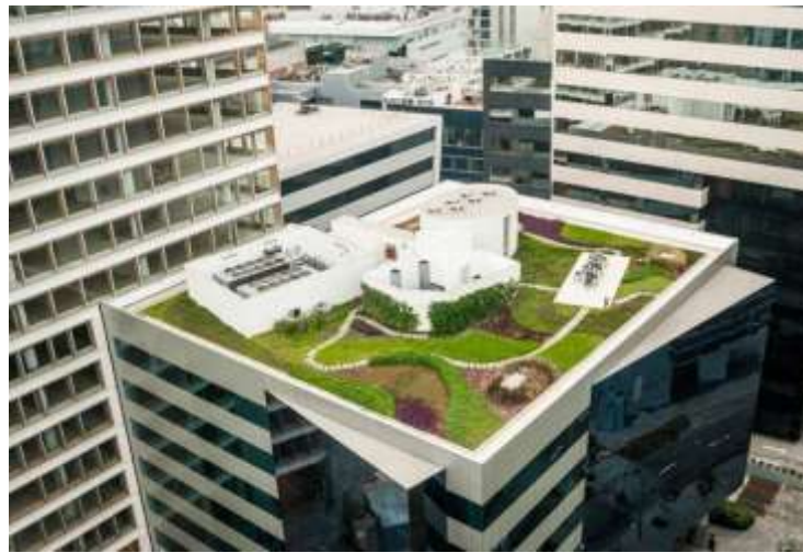
Figura 64: Cubierta verde del edificio Real Seis, San Isidro, Lima. Fuente: (El Comercio, 2013)
