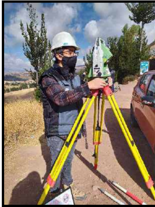
Figura n° 52: Nivelado y configuración de la Estación Total
