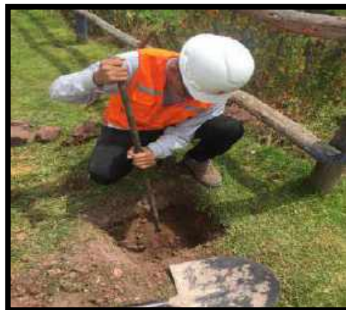
Figura n° 36: Excavación 0.40 x 0.40 m para los puntos de control
