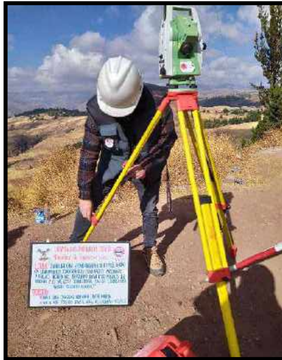
Figura n° 51: Armado del trípode de la Estación Total
