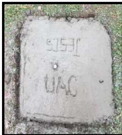
Figura n° 40: Modelo de Punto de Control con mezcla de concreto fraguada
