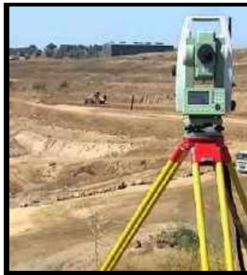
Figura n° 4: Levantamiento Topográfico planimétrico con Estación Total
