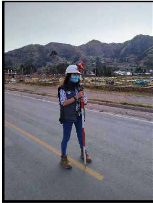
Figura n° 56: Toma de puntos (Prismeado) del Eje de la Vía
