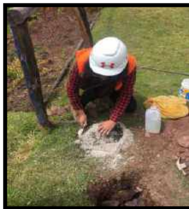
Figura n° 37: Preparado de la mezcla de concreto
