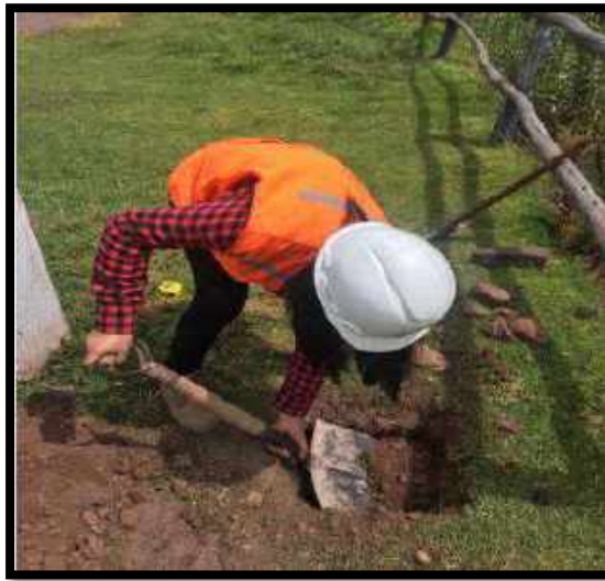
Figura n° 35: Retirado del material excedente de la excavación
