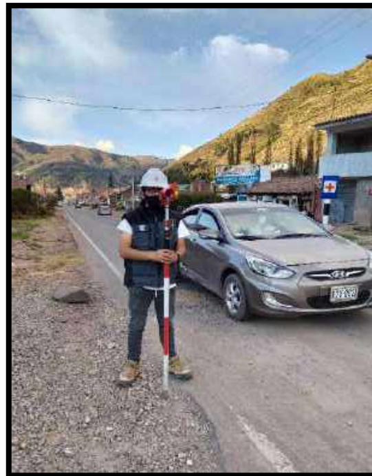
Figura n° 54: Toma de puntos (Prismeado) de los extremos laterales de la vía
