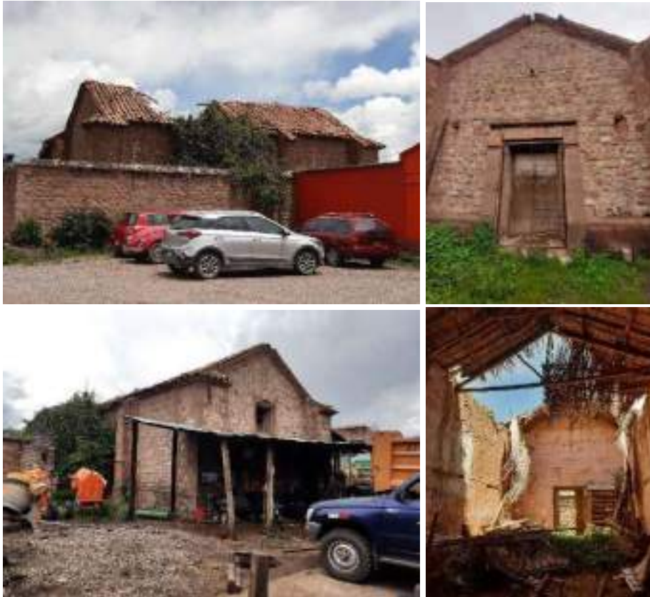
Figura 57: Imágenes del estado actual del Polvorín de San Carlos. Fuente: Elaboración Propia.
