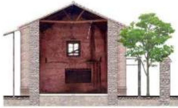
Figura 50: Fotomontaje del estado actual del almacén mayor de pólvora, donde se evidencia la estructura de techo. Fuente: Elaboración propia.
