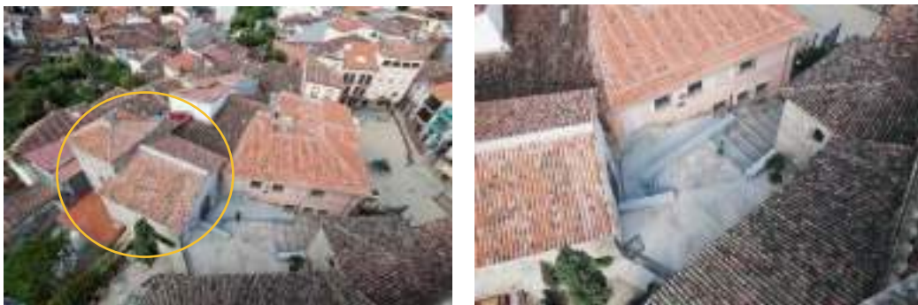
Figura 12: Fotografías Aéreas del Emplazamiento del proyecto en el terreno. Fuente: ArchDaily.
