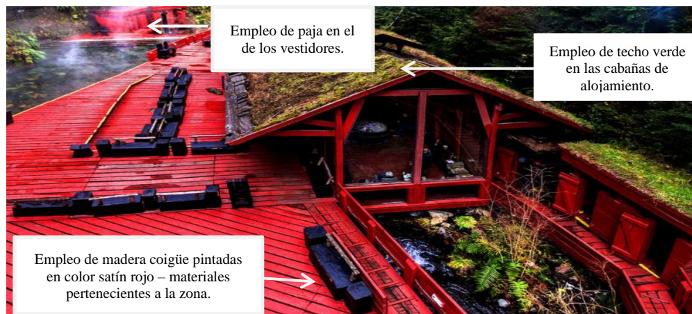
Figura 11. Análisis de las estrategias bioclimáticas pasivas aplicadas en las “termas geométricas”.
