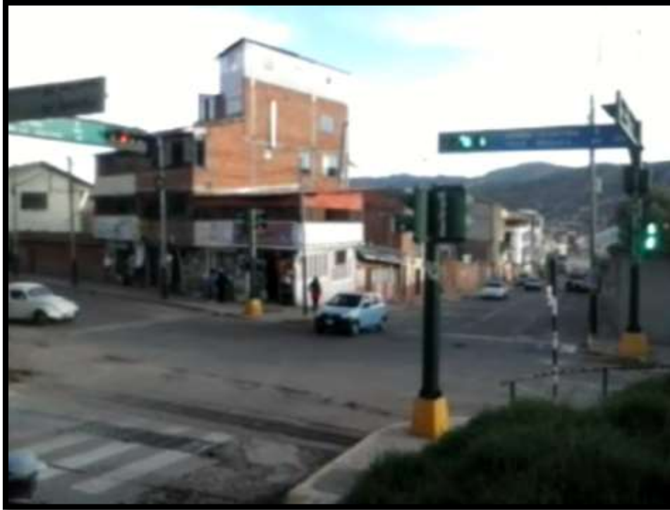
Figura 52: Volúmenes vehiculares en la intersección semaforizada Calle Recoleta (Av. Argentina) - Calle Retiro Fuente: Elaboración propia
