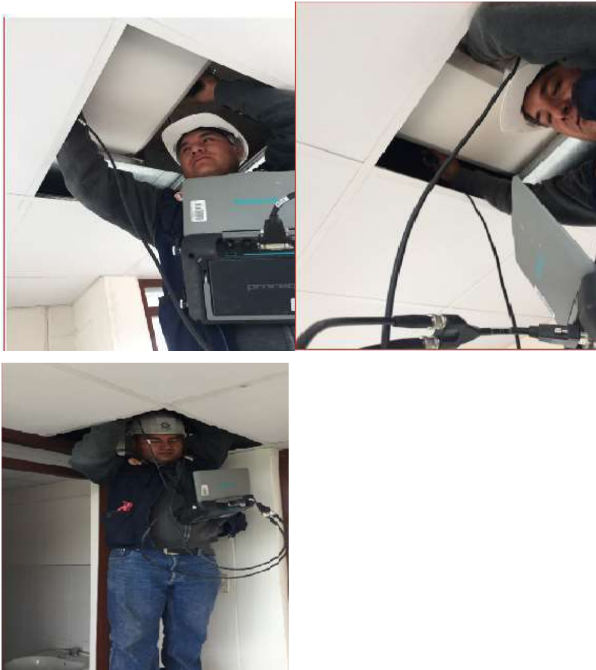
Figura 53 -Ensayo Ultra sonido- resistencia a la compresión Pundit PL interior-externo en vigas del Cuarto nivel de la tribuna Occidente de los anillos del estadio Inca Garcilaso de la Vega.
