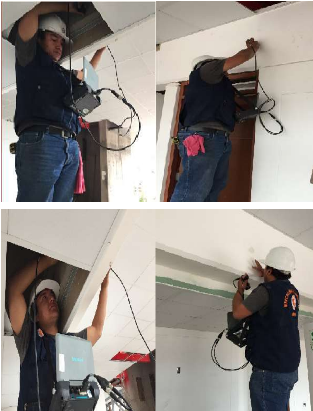
Figura 54 -Ensayo Ultra sonido- resistencia a la compresión Pundit PL interior-externo en vigas del Quinto nivel de la tribuna Occidente de los anillos del estadio Inca Garcilaso de la Vega.
