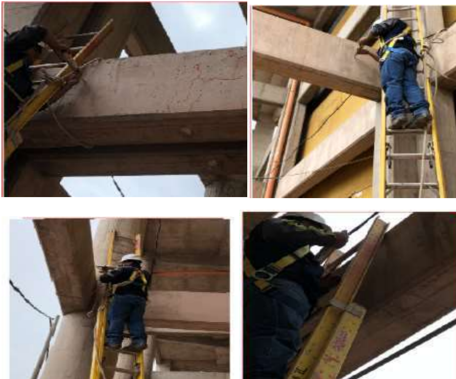
Figura 32 - Ensayo esclerómetro interior-externo en vigas del Segundo nivel de la tribuna Oriente de los anillos del estadio Inca Garcilaso de la Vega
