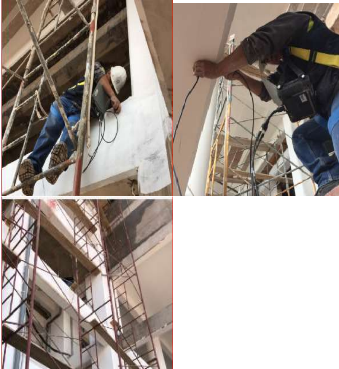
Figura 51 - Ensayo Ultra sonido- resistencia a la compresión Pundit PL interior-externo en vigas del Segundo nivel de la tribuna Occidente de los anillos del estadio Inca Garcilaso de la Vega.
