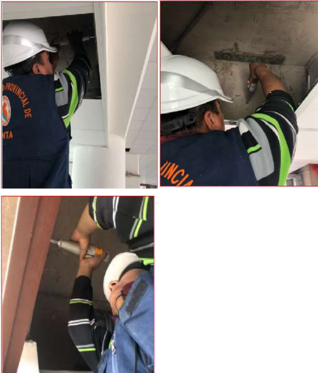
Figura 37 - Ensayo esclerómetro interior-externo en vigas del segundo nivel de la tribuna Occidente de los anillos del estadio Inca Garcilaso de la Vega
