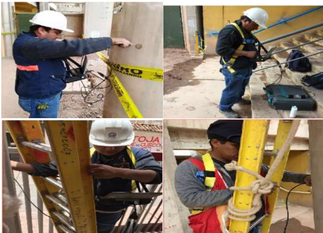
Figura 38 -Ensayo Ultra sonido- resistencia a la compresión Pundit PL interior-exterior en vigas del Primer nivel de la tribuna Oriente de los anillos del estadio Inca Garcilaso de la Vega
