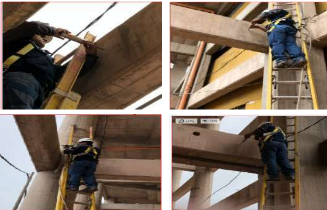
Figura 31 - Ensayo esclerómetro interior-externo en vigas del Primer nivel de la tribuna Oriente de los anillos del estadio Inca Garcilaso de la Vega
