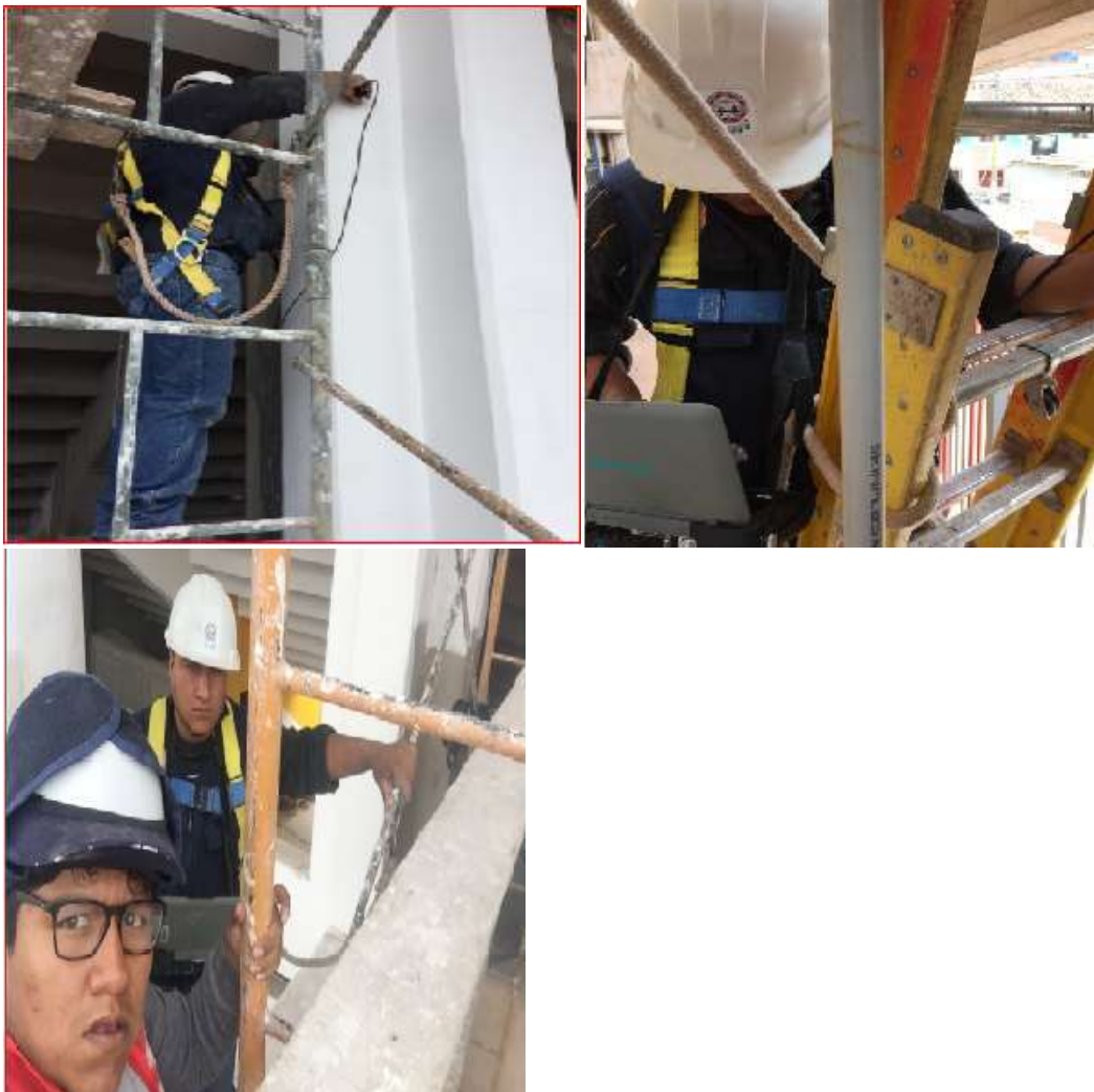
Figura 43 - Ensayo Ultra sonido- resistencia a la compresión Pundit PL interior-externo en vigas del Segundo nivel de la tribuna Occidente de los anillos del estadio Inca Garcilaso de la Vega
