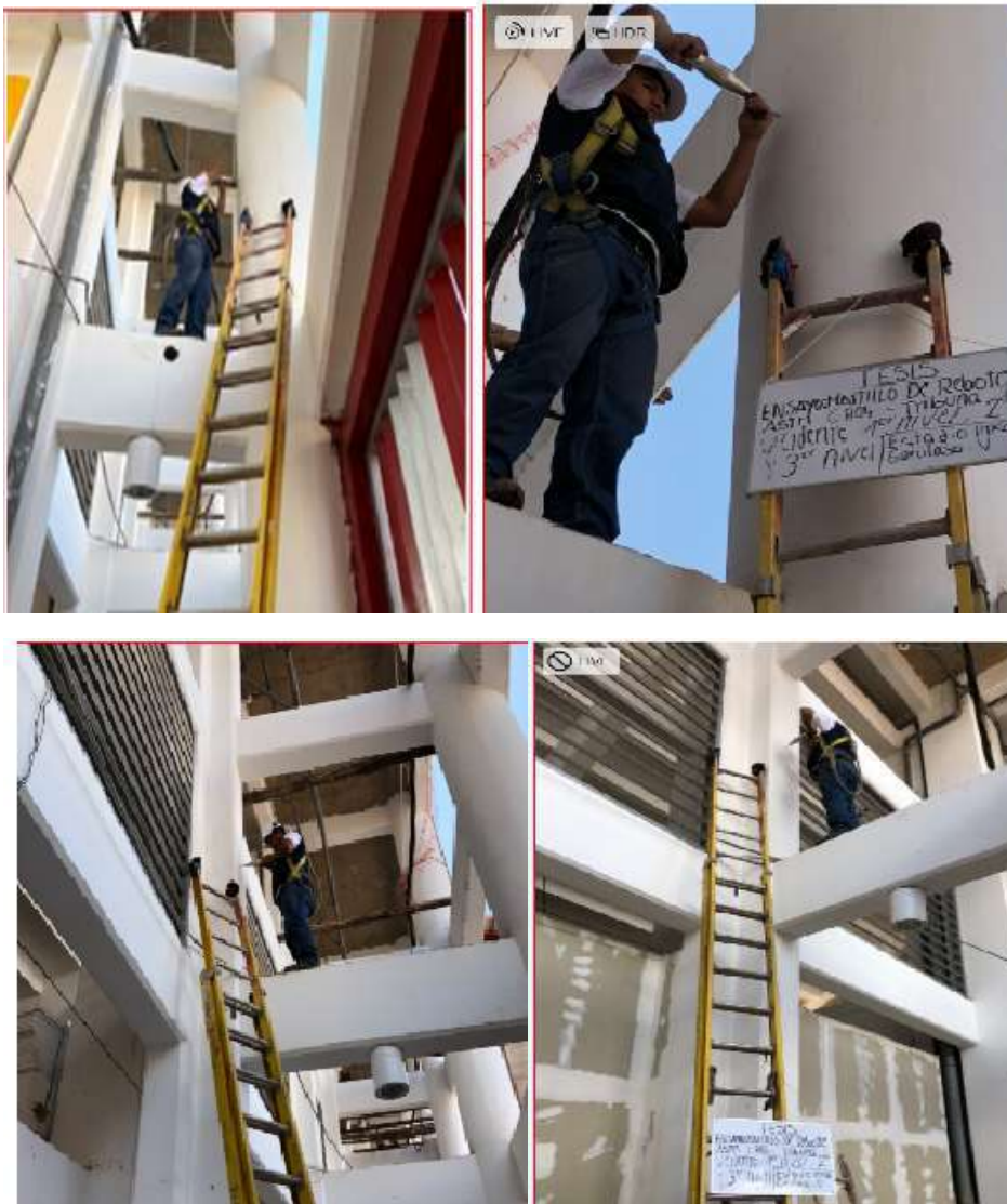
Figura 27 - Ensayo esclerómetro interior-externo en columnas segundo nivel de la tribuna occidente de los anillos del estadio Inca Garcilaso de la Vega
