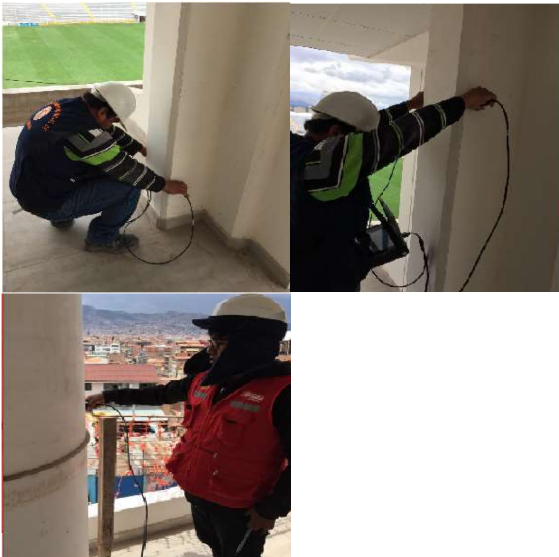
Figura 46 - Ensayo Ultra sonido- resistencia a la compresión Pundit PL interior-exterior en vigas del Quinto nivel de la tribuna Occidente de los anillos del estadio Inca Garcilaso de la Vega.
