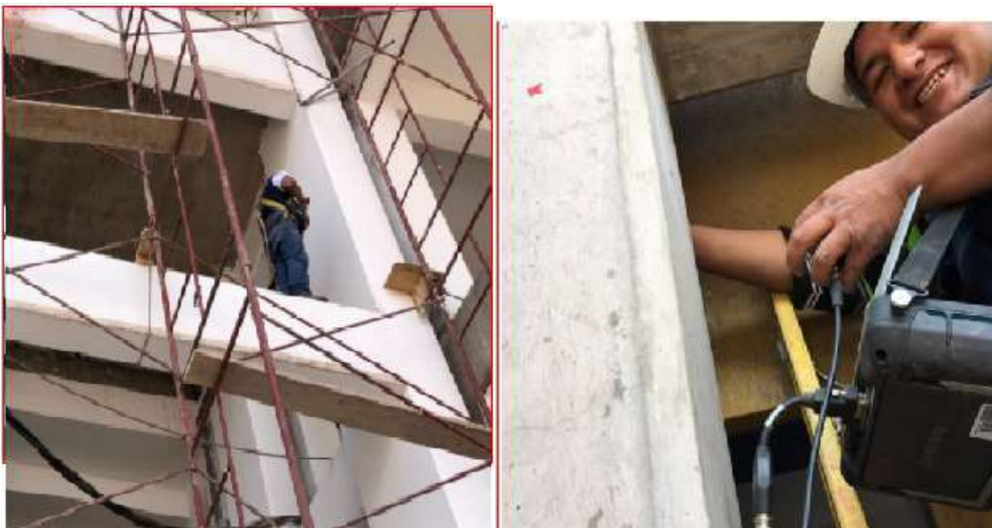
Figura 44 - Ensayo Ultra sonido- resistencia a la compresión Pundit PL interior-exterior en vigas del Tercer nivel de la tribuna Occidente de los anillos del estadio Inca Garcilaso de la Vega.
