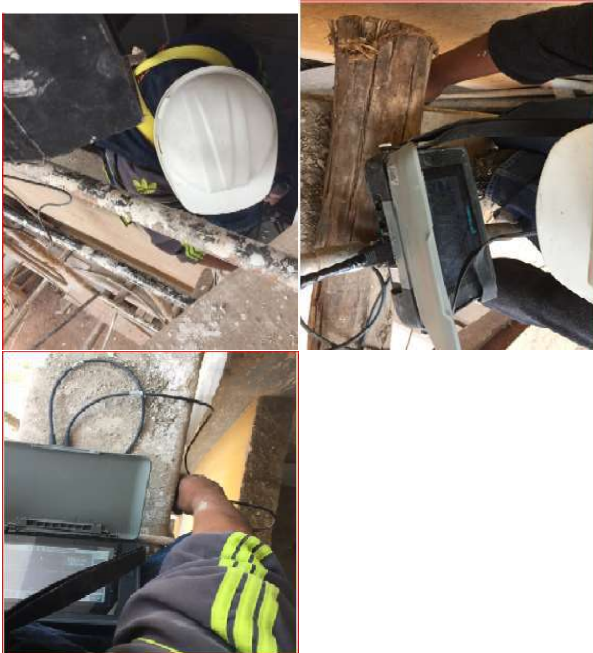
Figura 49 - Ensayo Ultra sonido- resistencia a la compresión Pundit PL interior-exterior en vigas del Tercer nivel de la tribuna Oriente de los anillos del estadio Inca Garcilaso de la Vega.
