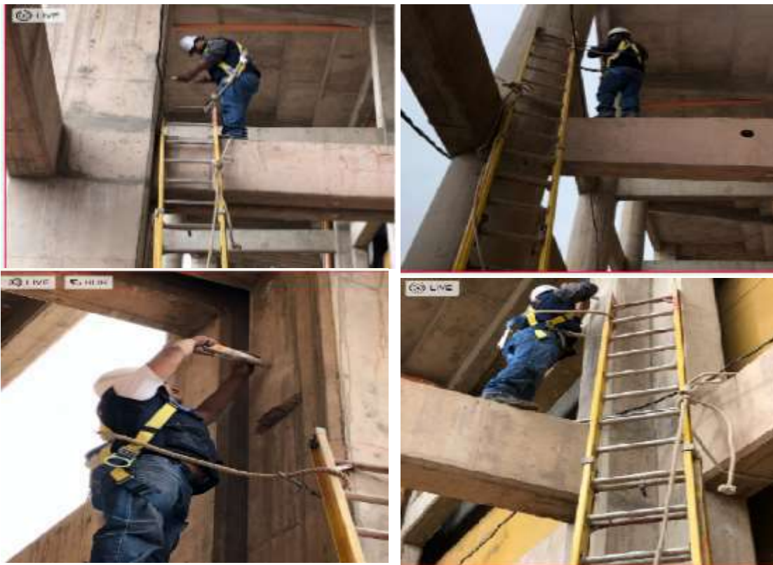
Figura 24 -Ensayo esclerómetro interior-exterior en columnas tercer nivel de la tribuna oriente de los anillos del estadio Inca Garcilaso de la Vega
