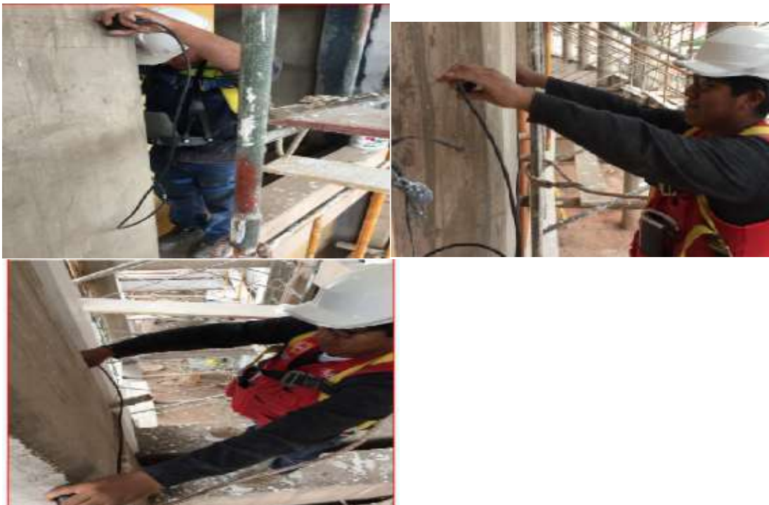
Figura 40 - Ensayo Ultra sonido- resistencia a la compresión Pundit PL interior-exterior en vigas del Tercer nivel de la tribuna Oriente de los anillos del estadio Inca Garcilaso de la Vega.
