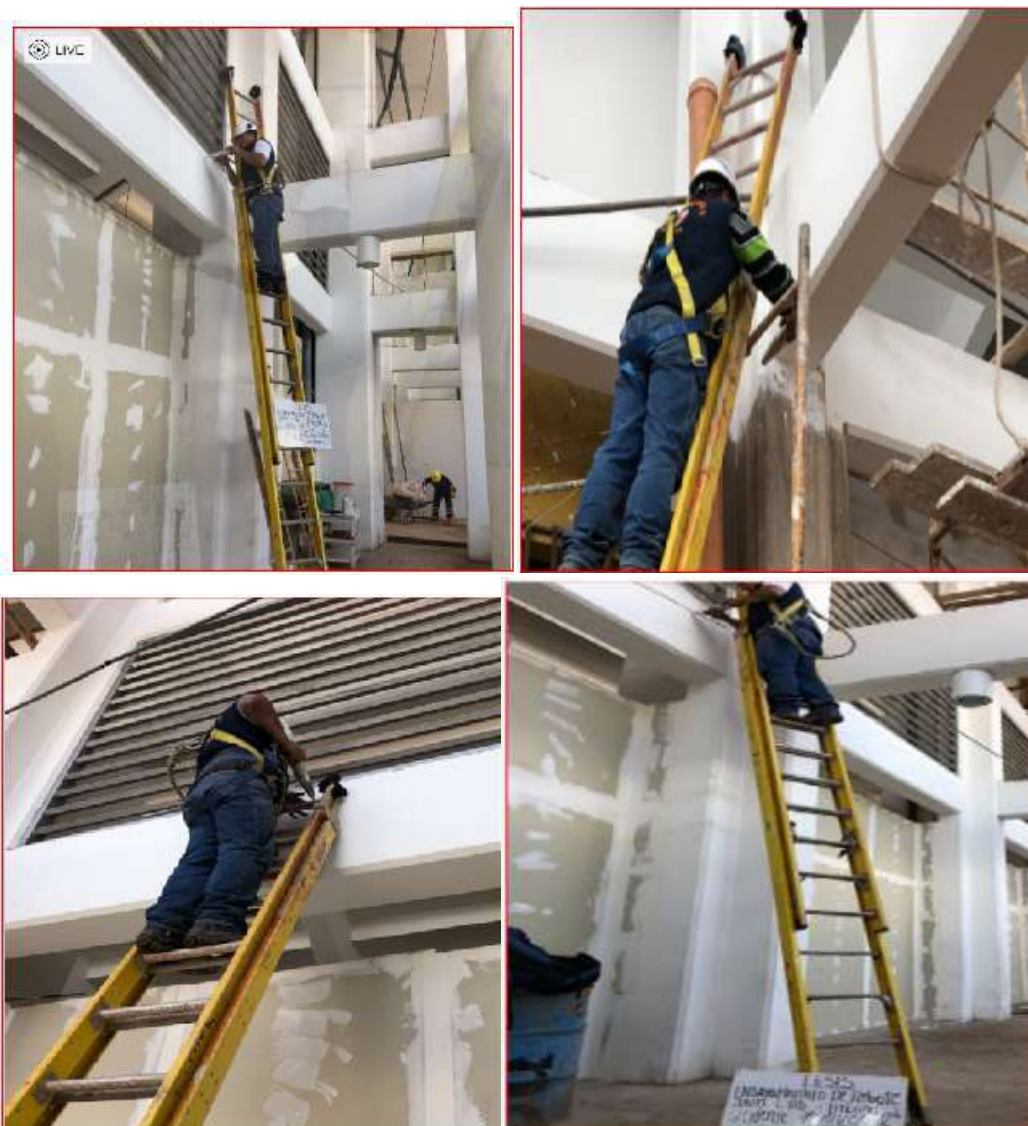
Figura 34 - Ensayo esclerómetro interior-externo en vigas del primer nivel de la tribuna Occidente de los anillos del estadio Inca Garcilaso de la Vega
