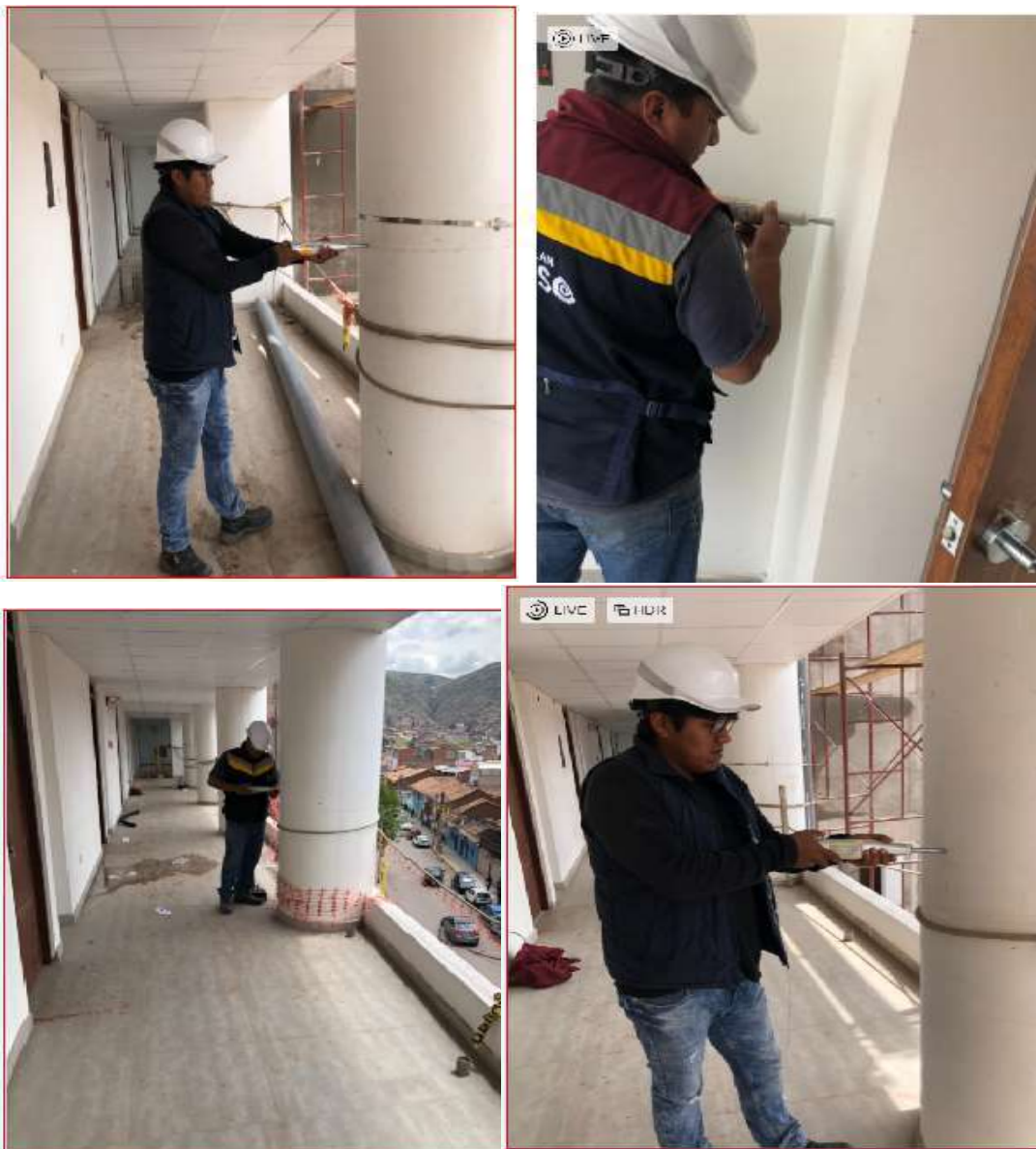
Figura 29 - Ensayo esclerómetro interior-externo en columnas cuarto nivel de la tribuna occidente de los anillos del estadio Inca Garcilaso de la Vega
