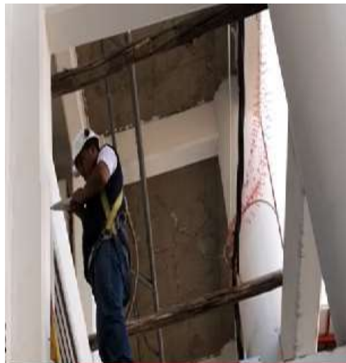
Figura 35 - Ensayo esclerómetro interior-externo en vigas del segundo nivel de la tribuna Occidente de los anillos del estadio Inca Garcilaso de la Vega
