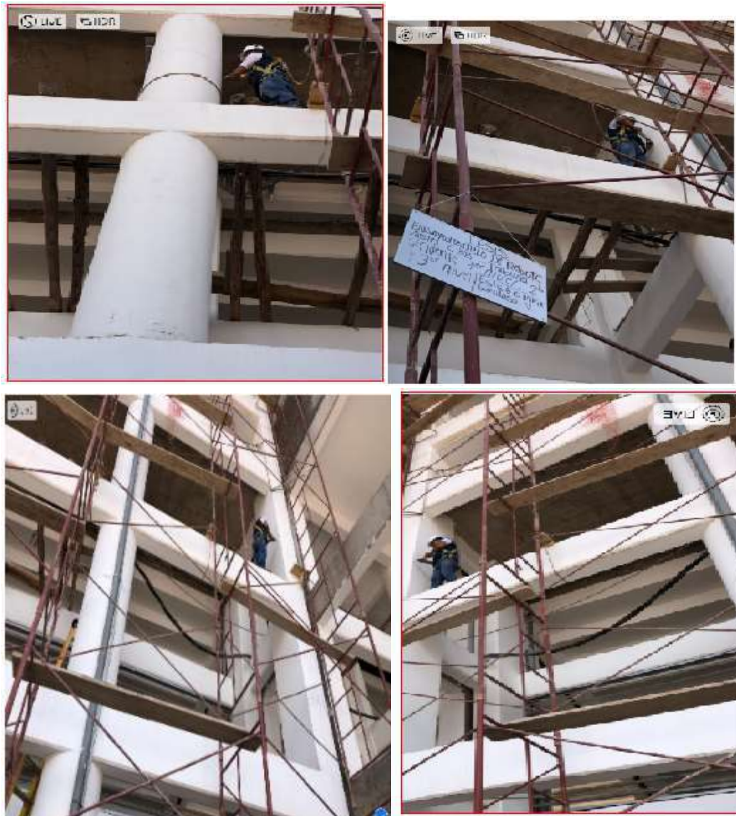
Figura 28 - Ensayo esclerómetro interior-exterior en columnas Tercer nivel de la tribuna occidente de los anillos del estadio Inca Garcilaso de la Vega
