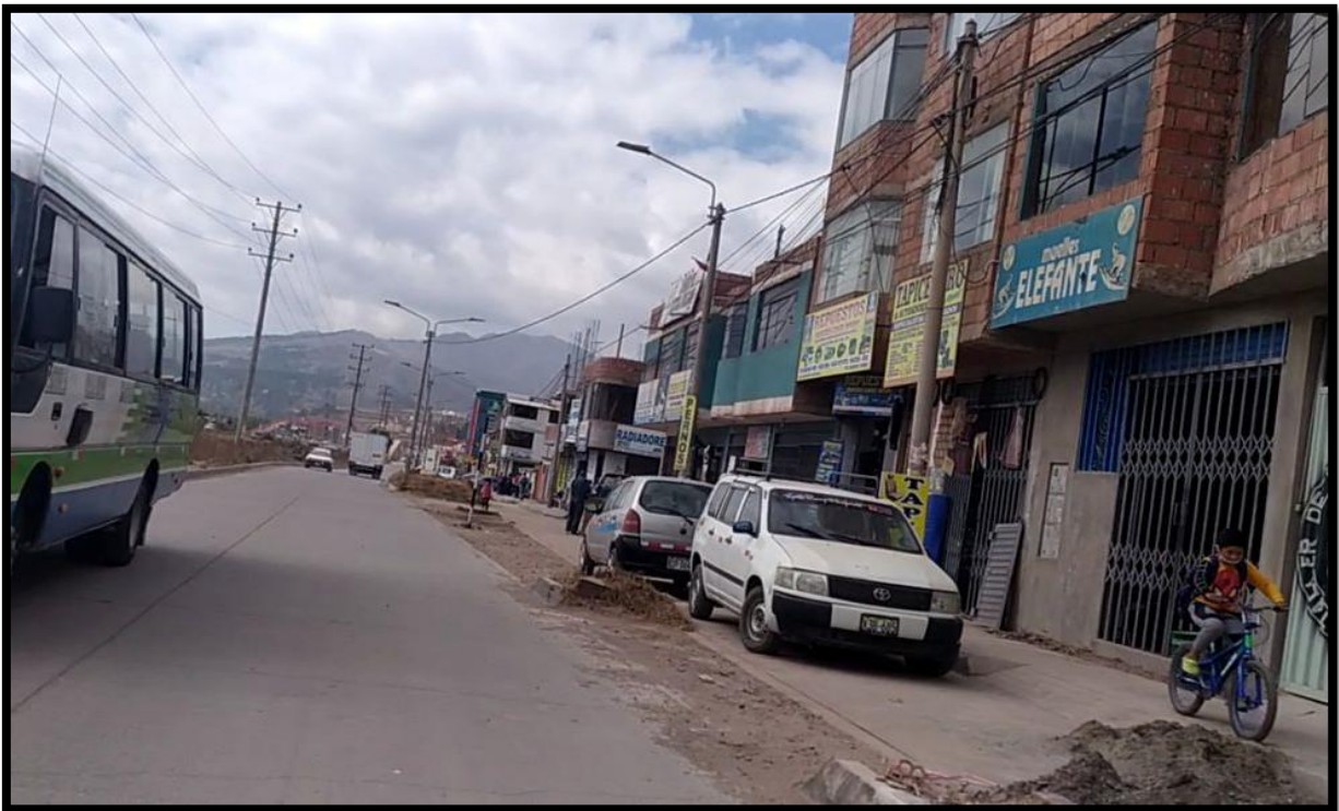
Figura 7: Ciclovía obstruida por autos y materiales de construcción Av. de Evitamiento
