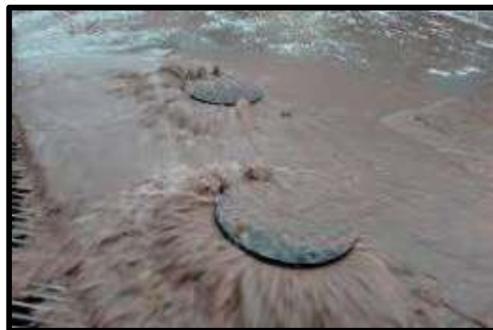
Figura N° 4: Colapso del sistema de alcantarillado en las calles de la ciudad del Cusco
