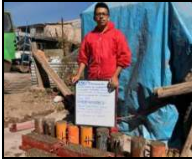
Figura N° 76: Desmoldado de especímenes de concreto permeable
