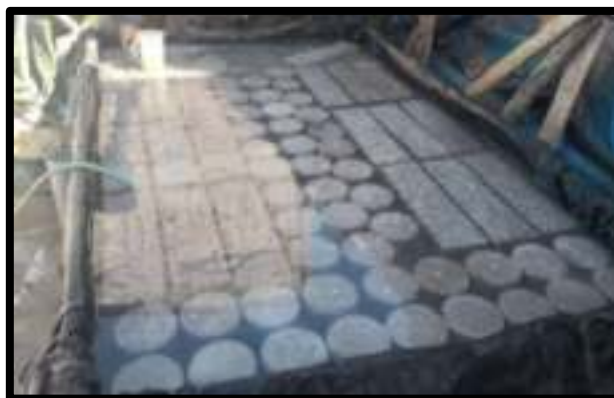
Figura N° 77: Curado de los especímenes de concreto permeable
