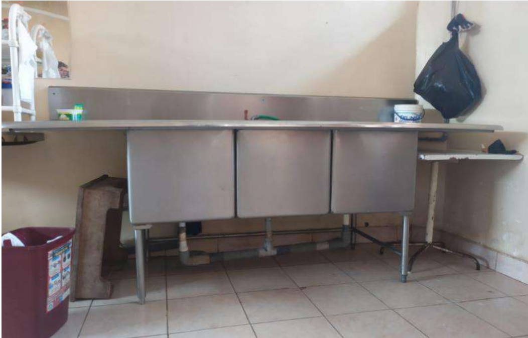
Figura 13. Pozas de desinfección
