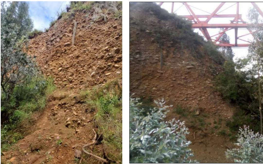
Figura 15: Talud izquierdo – Trinchera para obtención de muestras Fuente: Propia
