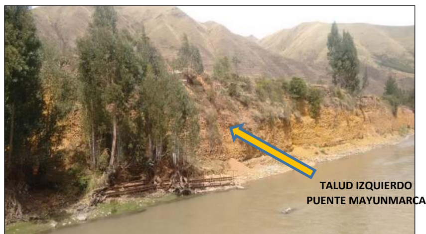
Figura 1: Talud Margen Izquierda del puente Mayunmarca Fuente: Elaboracion Propia
