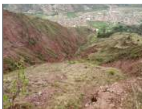
Figura 92 Vista de la quebrada, desde la parte superior
