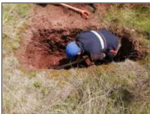
Figura 87 Realización de la calicata 01
