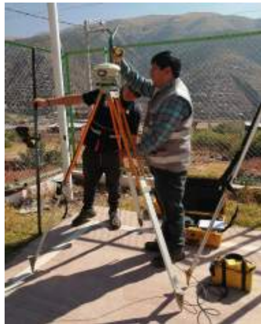
Figura 55 Proceso de instalación del GPS Diferencial
