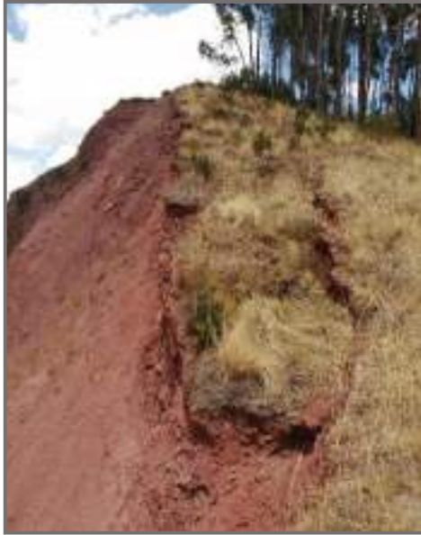
Figura 29 Formación de grietas y material suelto
