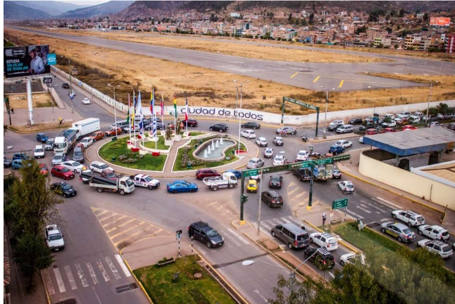
Figura 3 Circulación vehicular en la intersección a nivel “Ovalo Libertadores”
