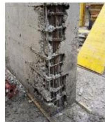
Figura 1: Concreto convencional con presencia de cangrejeras.
