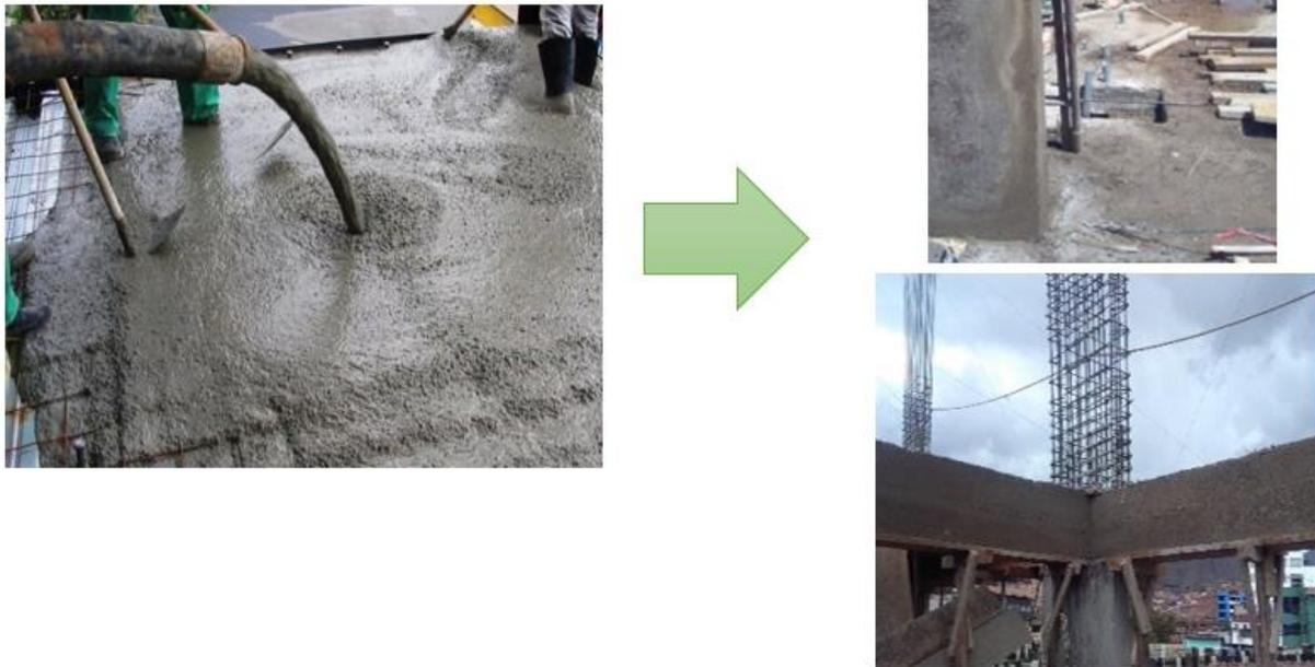
Figura 2: Concreto aditivado con superplastificante con una mejor homogeneidad en la mezcla y posterior acabo.
