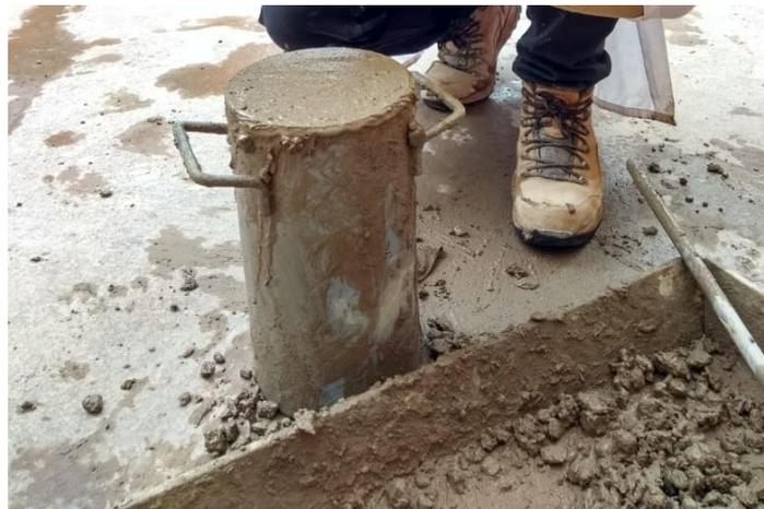
Figura 89: Enrasado del concreto
