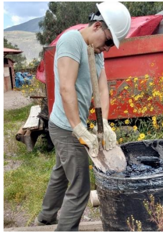
Figura 126: Extracción de asfalto de la planta de asfalto del Gobierno Regional del Cusco
