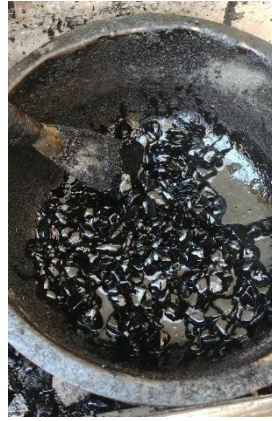
Figura 131: Mezcla lista para compactar
