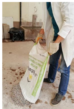
Figura 27: Extender el agregado en una superficie limpia
