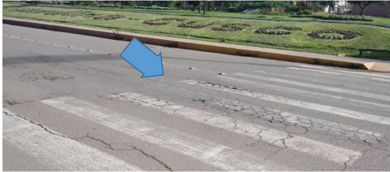
Figura 2: Piel de cocodrilo (fatiga) en la Prolongación Av. De la Cultura (frente a la Universidad Andina del Cusco)
