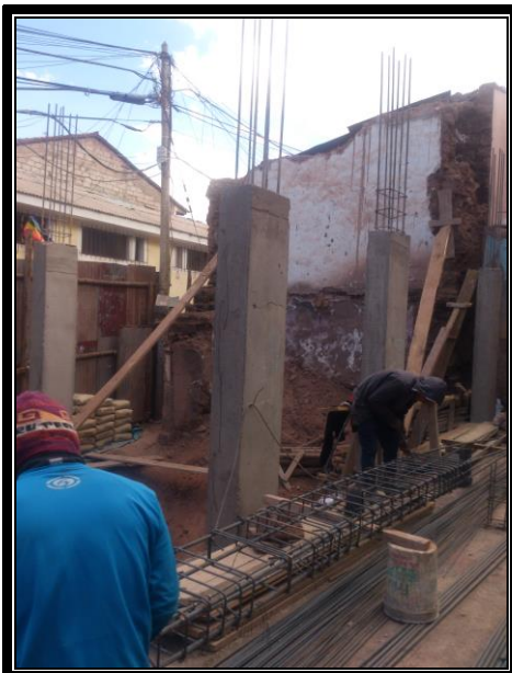
F6 Personal armando columnas con dificultad por falta de espacio.
