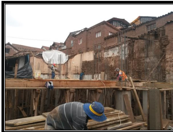
F1 Cuadrilla para encofrado: Personal obrero encofrando para vaciado de losa.
