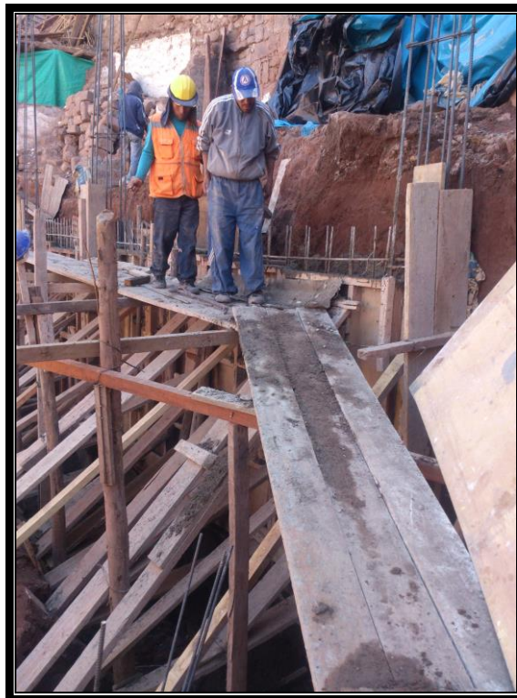
Figura 17. Verificación después del vaciado de muro de sostenimiento.
