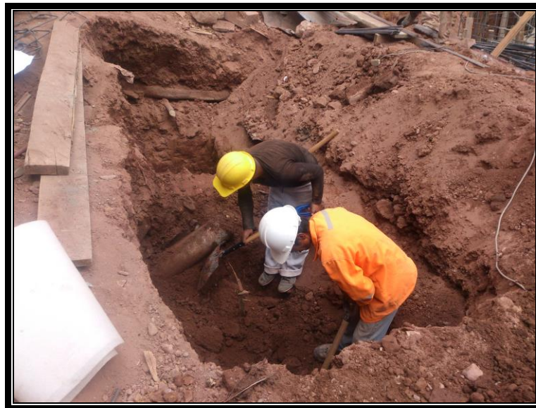
Figura 15. Personal haciendo excavación manual de terreno.
