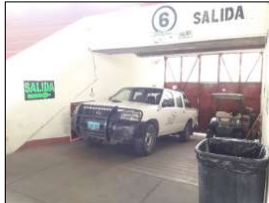
Figura 98. Recolección de datos en el Tramo 6 –interior Coliseo Casa de la Juventud - rampas
