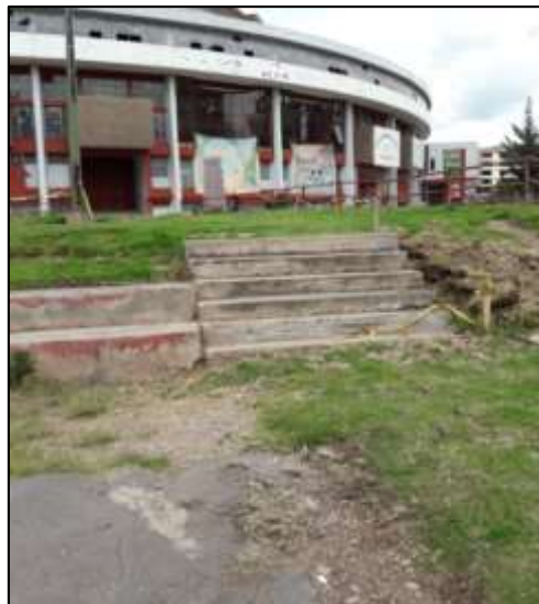
Figura 81. Recolección de datos en el Tramo 1 –interior IPD rampas
