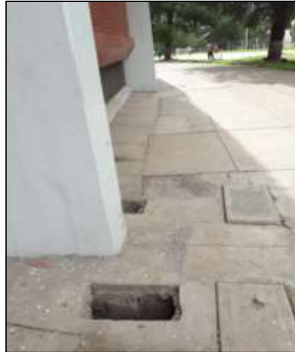
Figura 61. Recolección de datos en el Tramo 4. Fuente: Elaboración propia.
