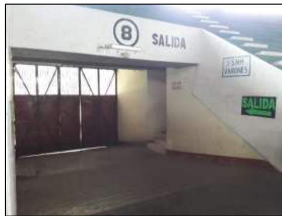
Figura 102. Recolección de datos en el Tramo 8 –interior Coliseo Casa de la Juventud - rampas
