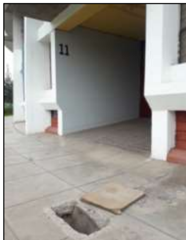
Figura 65. Recolección de datos en el Tramo 6. Fuente: Elaboración propia.
