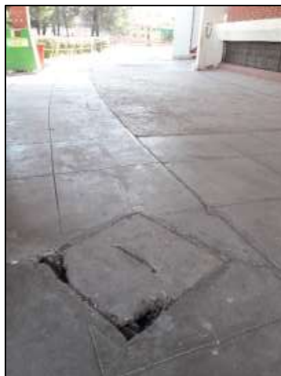
Figura 63. Recolección de datos en el Tramo 5. Fuente: Elaboración propia.
