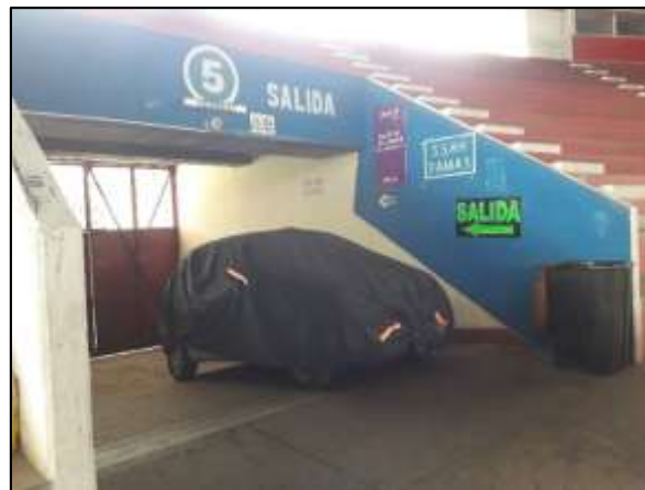
Figura 96. Recolección de datos en el Tramo 5 –interior Coliseo Casa de la Juventud - rampas
