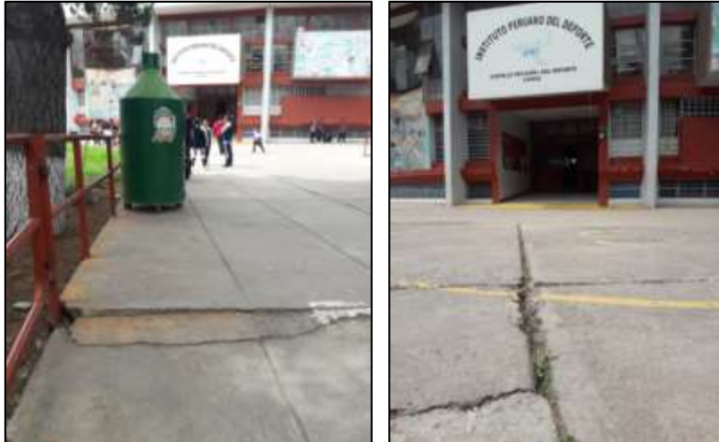
Figura 67. Recolección de datos en el Tramo 7. Fuente: Elaboración propia.
