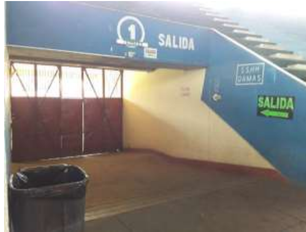
Figura 88. Recolección de datos en el Tramo 1 –interior Coliseo Casa de la Juventud - rampas
