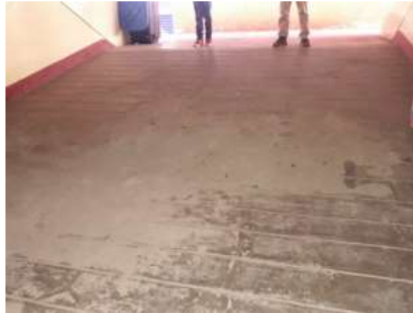
Figura 85. Recolección de datos en el Tramo 4 –interior IPD rampas Fuente: Elaboración propia.
