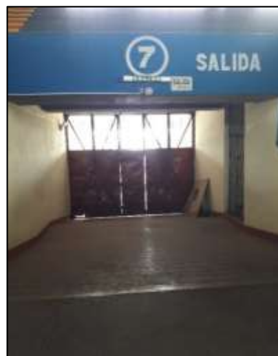
Figura 100. Recolección de datos en el Tramo 7 –interior Coliseo Casa de la Juventud - rampas
