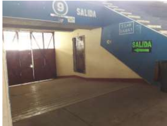
Figura 104. Recolección de datos en el Tramo 9 –interior Coliseo Casa de la Juventud – rampas
