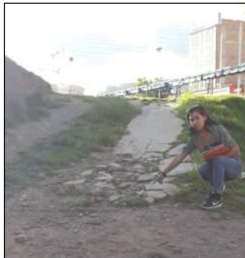
Figura 83. Recolección de datos en el Tramo 2 –interior IPD rampas
