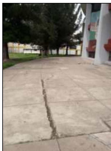
Figura 57. Recolección de datos en el Tramo 2. Fuente: Elaboración propia.
