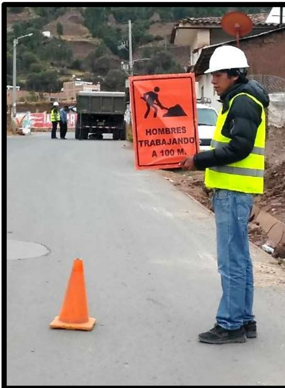
Figura 101. Señales informativas a 100 m antes de la evaluación del punto de ensayo. Fuente: Elaboración propia 2019
