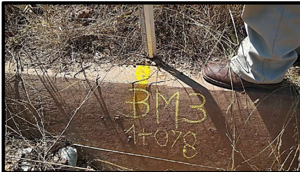
Figura 76. Se ubicó y marcó con pintura CATERPILLAR los BM's de nivelación, aproximadamente a 1 BM cada 500 metros. Fuente: Elaboración propia 2019
