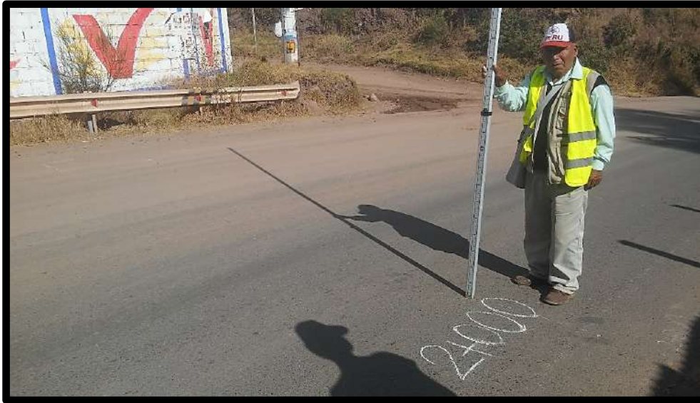
Figura 81. Nivelación en la progresiva relativa 2+000 km, en el Sector T'icapata. Fuente: Elaboración propia 2019.
