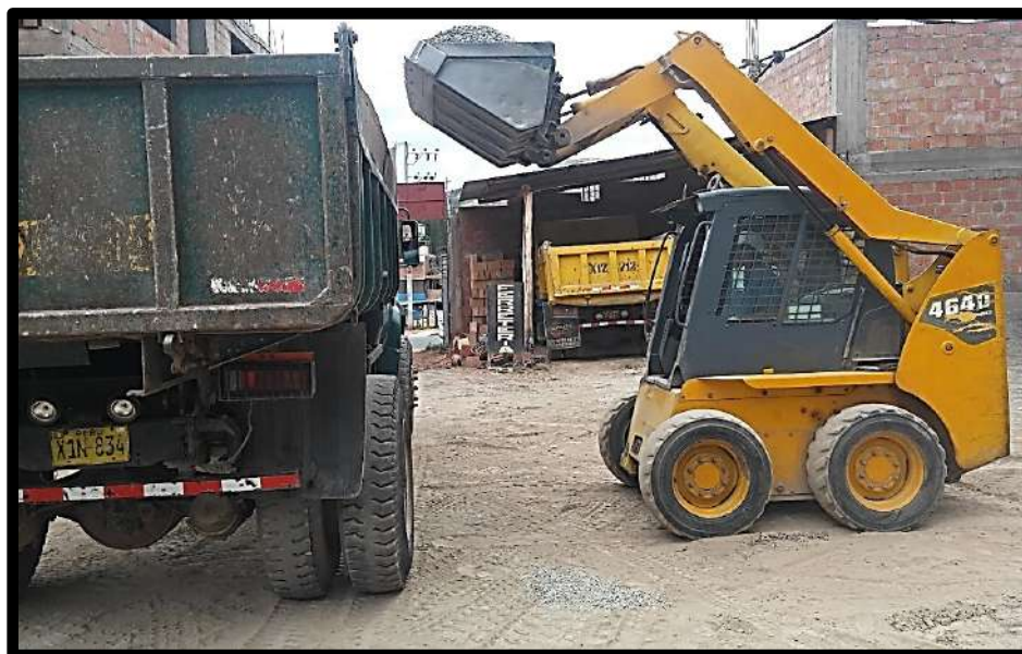
Figura 91. Cargado del camión en la tolva posterior del camión con piedra chancada de 1/2". Fuente: Elaboración propia 2019
