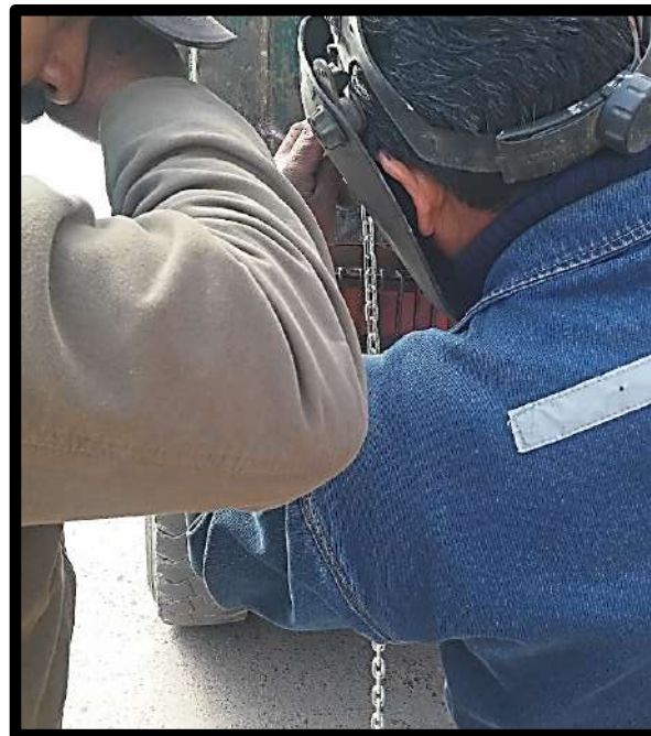
Figura 96. Soldado de una cadena en la parte posterior que servirá de plomada en el ensayo. Fuente: Elaboración Propia 2019
