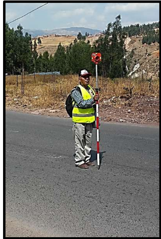
Figura 60. Disparo con láser de la Estación Total al prisma ubicado en el eje, bordes y cunetas de la vía. Fuente: Elaboración propia 2019
