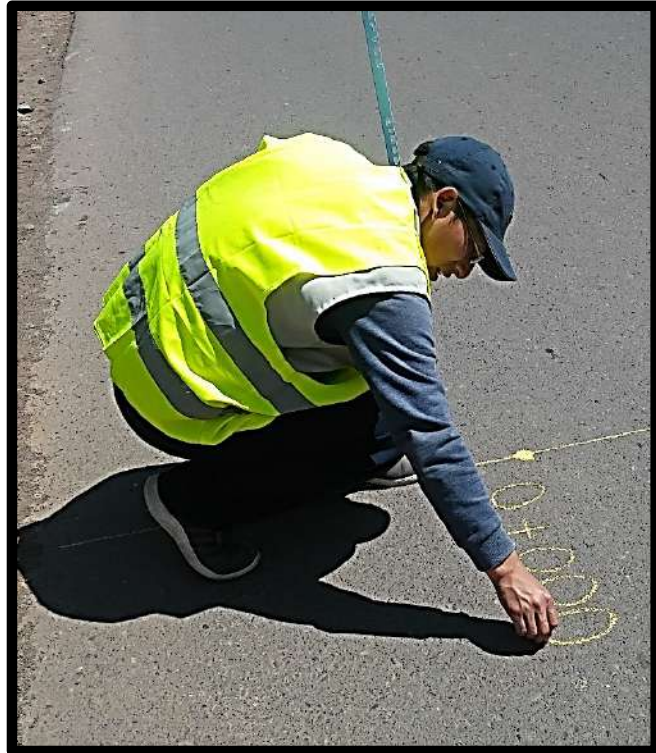
Figura 65. Progresiva relativa 0+000 Km equivalente a la progresiva 3+834 Km, del carril de descendente, para la evaluación funcional en el sector de la CC de Pumamarca. Fuente: Elaboración propia 2019
