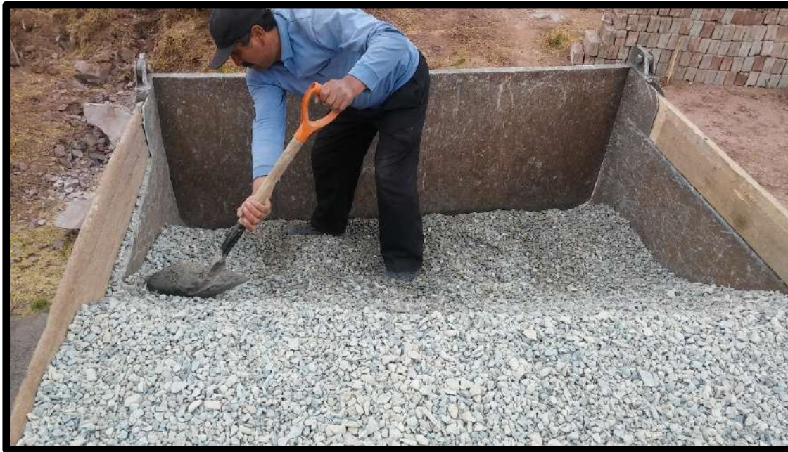
Figura 92. Extendido de la piedra chancada en la tolva, a una altura aproximadamente uniforme. Fuente: Elaboración Propia 2019
