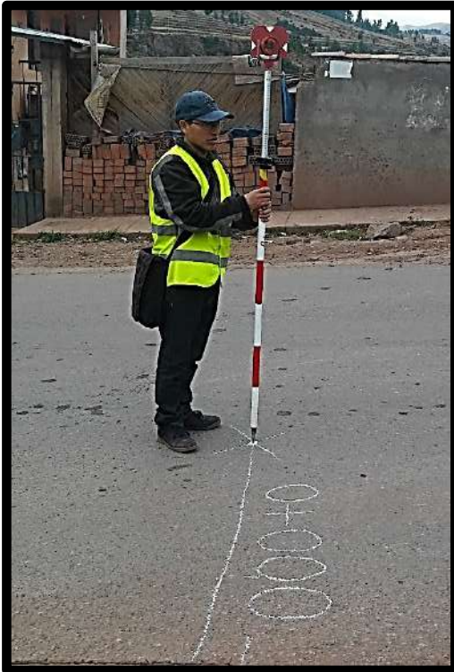
Figura 66. Progresiva relativa 0+000 Km equivalente a la progresiva 1+683 Km, en el carril de ascendente, para la evaluación estructural en el sector de T'icapata. Fuente: Elaboración propia 2019
