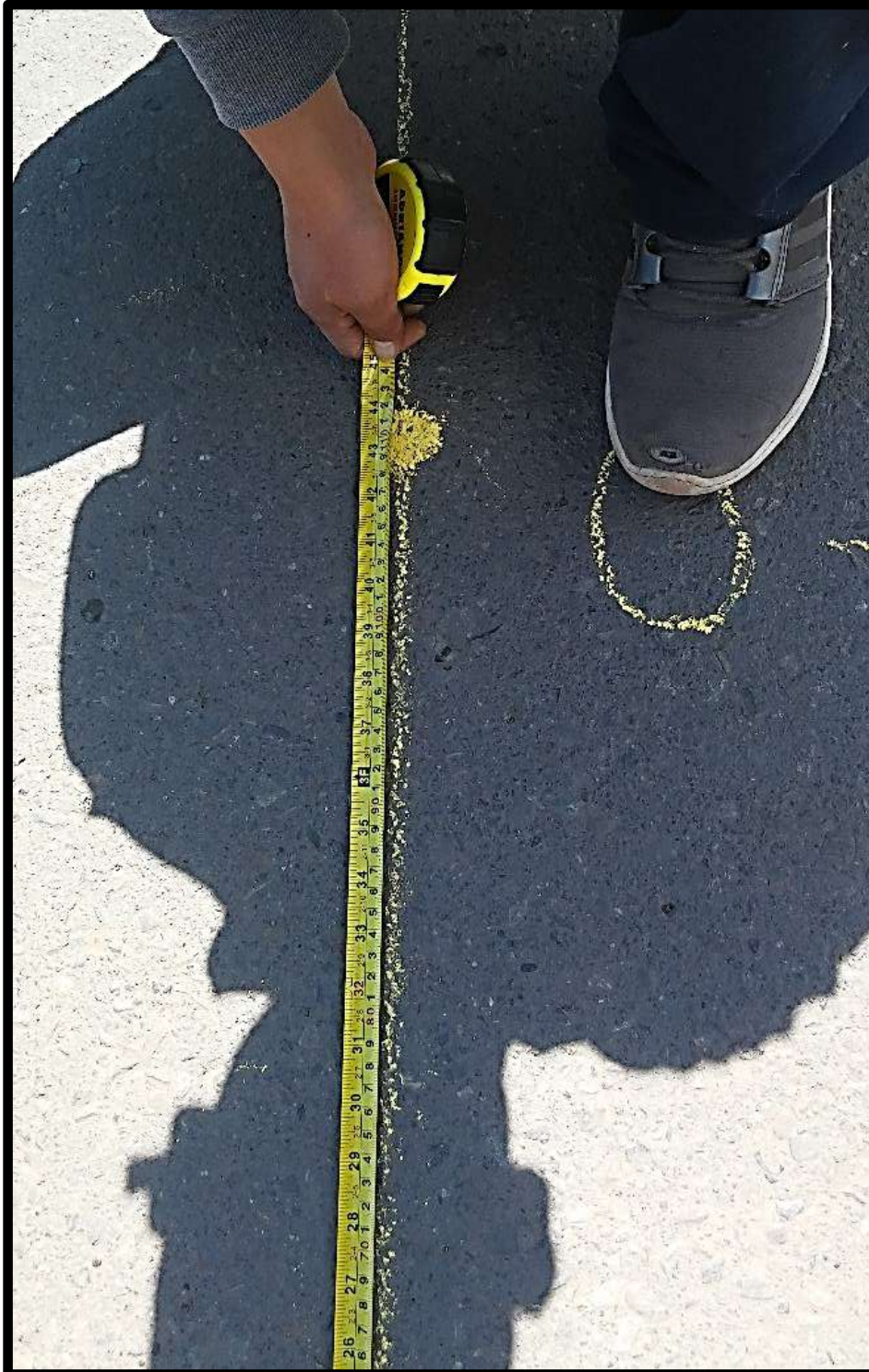
Figura 73. Ubicación de la línea longitudinal a 1.10 m del borde del pavimento. Fuente: Elaboración propia 2019
