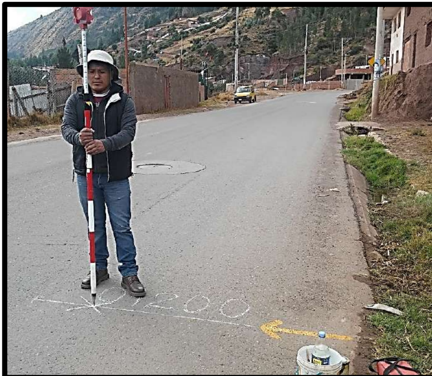
Figura 70. Replanteo cada 100 m desde Sector de T'icapata hasta la CC de Pumamarca en el carril de ascendente. Fuente: Elaboración propia.
