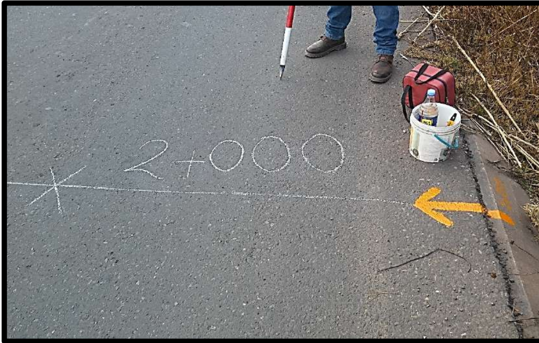
Figura 69. Marcado con tiza del punto de replanteo en la mitad del carril y con pintura en el borde del pavimento. Fuente: Elaboración propia 2019.
