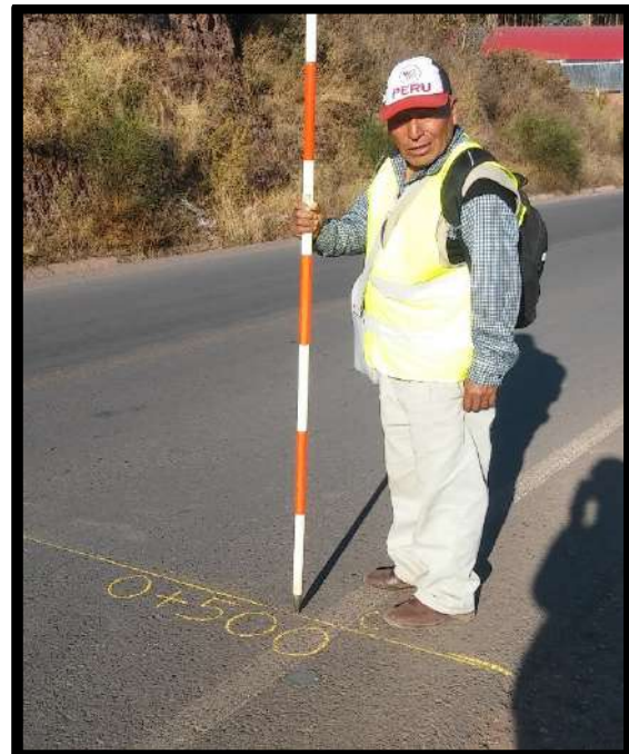
Figura 68. Replanteo cada 100 m desde CC Pumamarca hasta Sector T'icapata en el carril de descendente. Fuente: Elaboración propia 2019.
