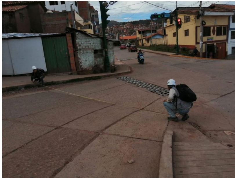
Figura 72: Toma de datos de la geometría de la vía en la intersección Av. Ayahuayco – Calle Nueva Alta.
