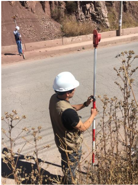
Figura 80: Toma de puntos de la vía Actual
