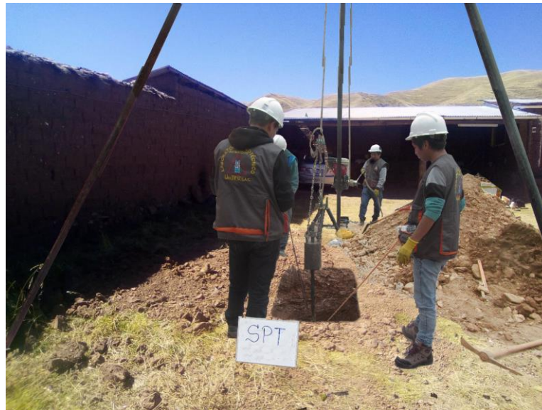
Figura 46. Proceso de perforación Fuente: elaboración propia.
