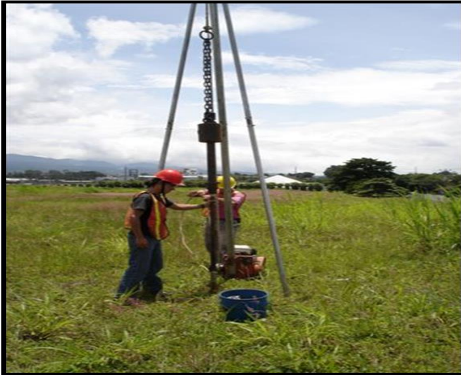
Figura 19. Realización del Ensayo SPT
