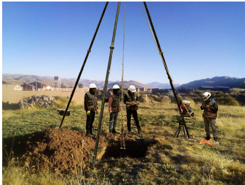
Figura 45. Instalación del SPT Fuente: Elaboración propia
