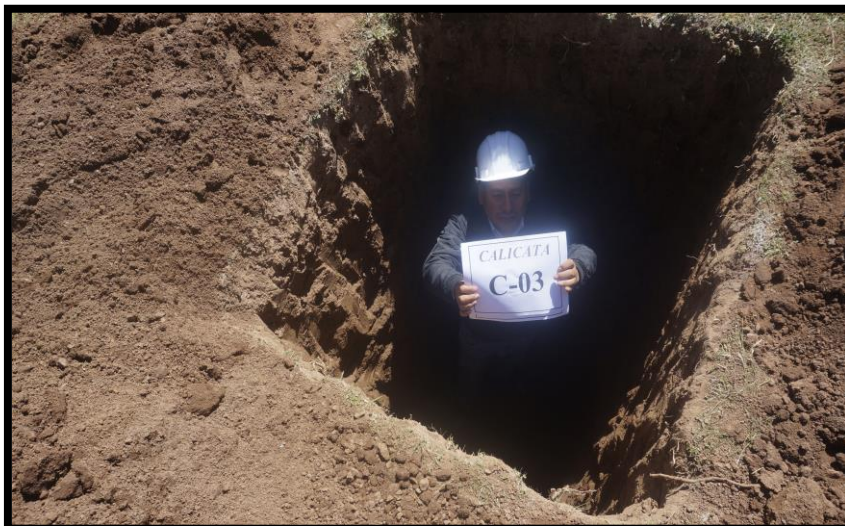
Figura 32. Realización de excavaciones a cielo abierto
