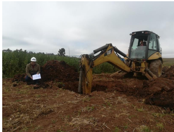
Figura 53. Excavación de calicatas con retroexcavadora
