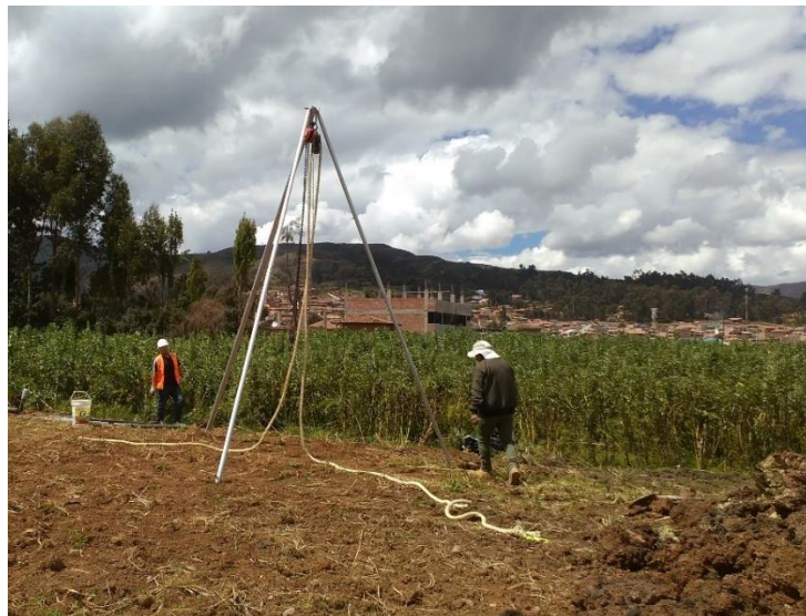
Figura 81. Armado del equipo de SPT
