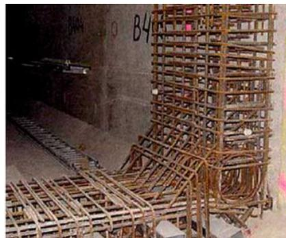
Figura 1: *Elemento estructural altamente reforzado*
