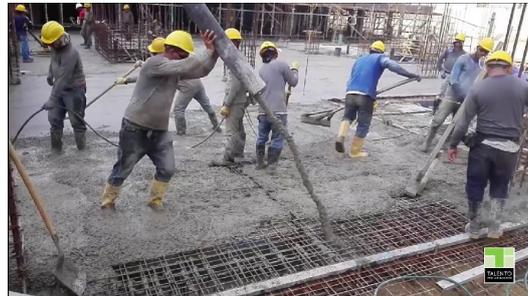
Figura 3: *Colocación de concreto convencional en Losa*
