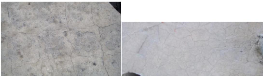
Figura 4: *Fisuras de Contracción*
