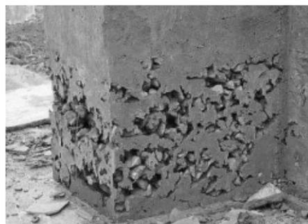
Figura 2: *Segregación del concreto y Aparición de Vacíos*
