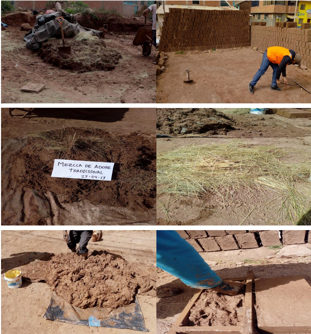
Figura 37: Procedimiento de la fabricación de los elementos de adobe tradicional
