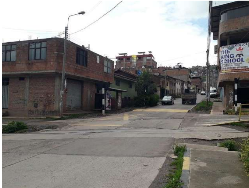
Figura N° 117 Paso a nivel con la línea férrea en Av. Humberto Vidal Unda Km 03+040
