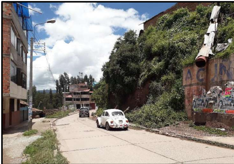
Figura N° 22 Taludes que impiden la correcta visibilidad 00+930 Km
