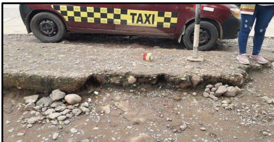
Figura N° 20 Veredas deterioradas que no cumplen con las condiciones necesarias 03+380 Km Lado izquierdo
