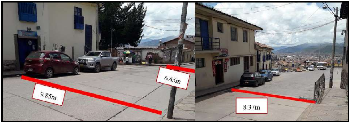
Figura N° 13. Variación de anchos de la calzada en 00+620 y 00+570 Km respectivamente.
