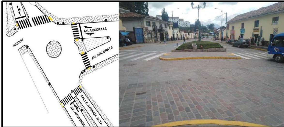
Figura N° 64 Isla elevada con sardinel
