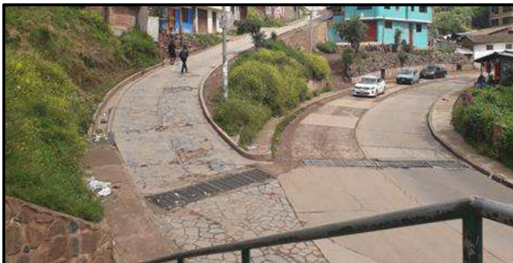
Figura N° 16 Ausencia de rampas en la intersección N° 13 Km 01+660
