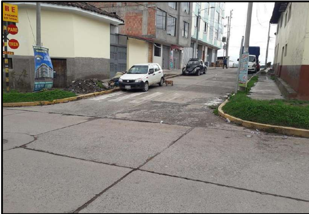
Figura N° 15 Ausencia de cruces peatonales, rampas y señales verticales en la intersección N° 19 Km 03+170 (Lado izquierdo)
