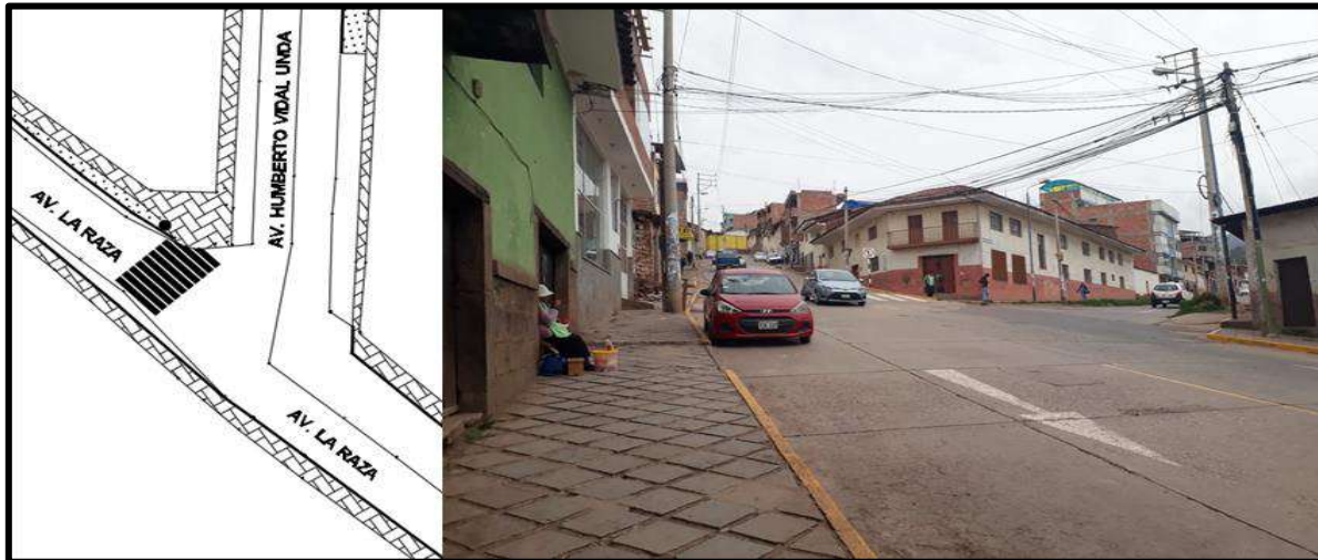
Figura N° 11. Intersección en conflicto Km 00+930
