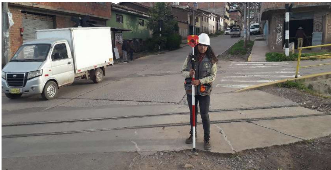
Figura N° 79 Prismeando en la intersección a nivel con la línea férrea Km 03+040
