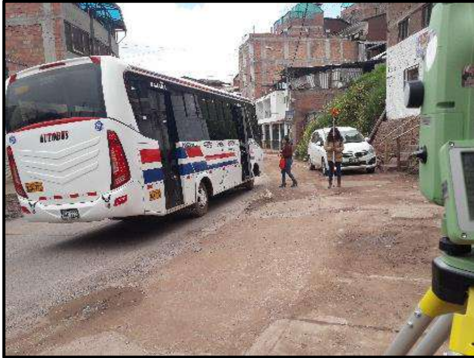
Figura N° 90 Prismeando el tramo de estudio Km 02+270
