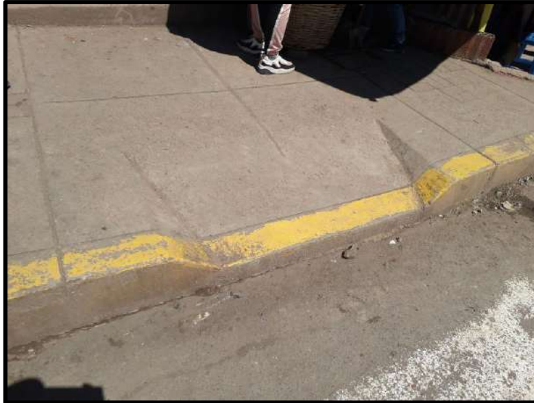
Figura N° 25 Rampa ubicada por encima del nivel Km 03+397
