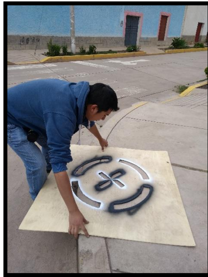
Figura 55: Colocación del molde para los puntos de control.
