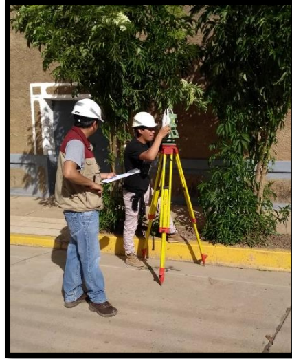
Figura 61: Nivelación y configuración de la estación total.
