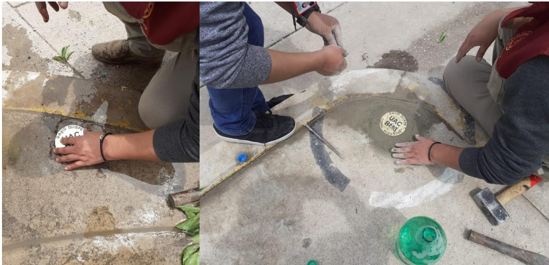
Figura 59: Colocación de las placas de bronce.
